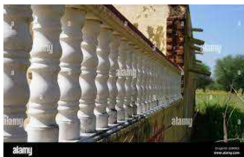
Fig. 33. Balustrade de balcon en pierre
