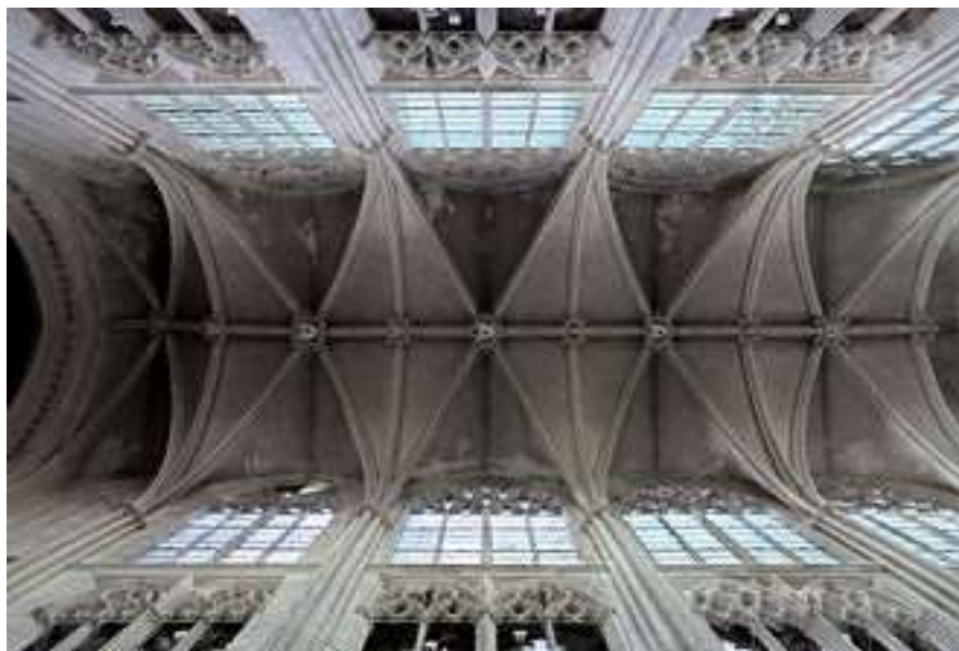
Fig. 37. Voûtes sur croisées d'ogives de la nef de la cathédrale Saint-Gatien de Tours
