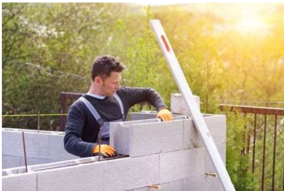
Fig. 26. Construction en maçonnerie
