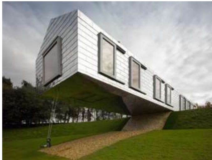
Fig. 45. Bâtiment en porte-à-faux
