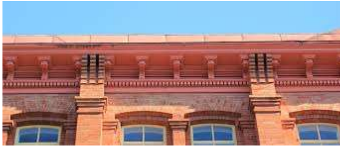
Fig. 40. Corniche d'un bâtiment Source : Corniche | Action patrimoine
