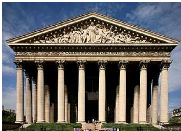
Fig. 35. Fronton triangulaire, placé au-dessus de l'entrée de l'église de la Madeleine, à Paris
