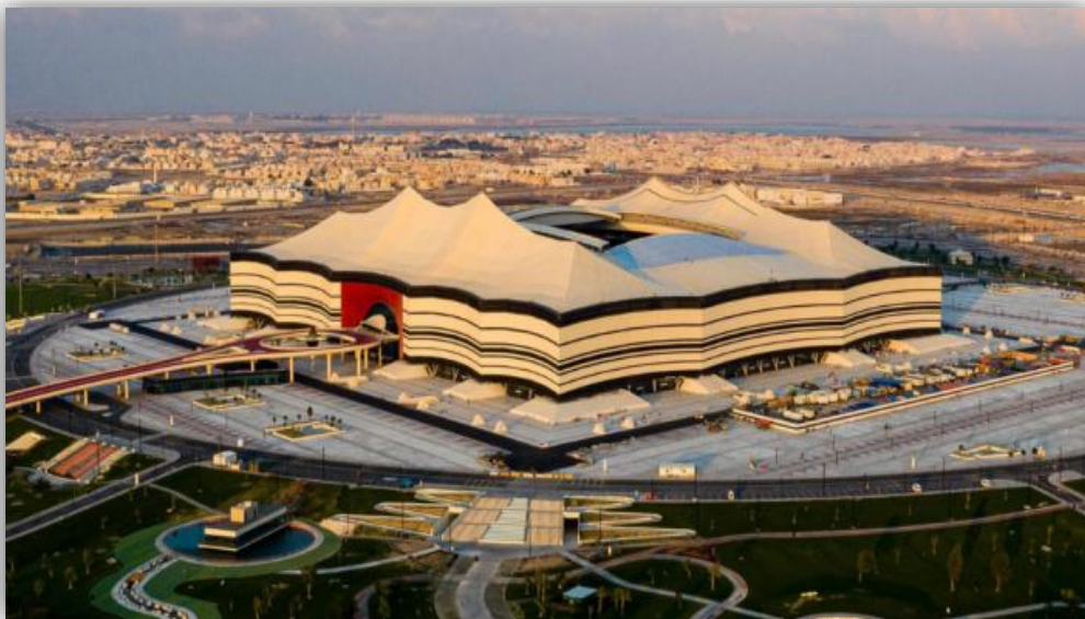
Bayt Al Sha’ar Stadium
