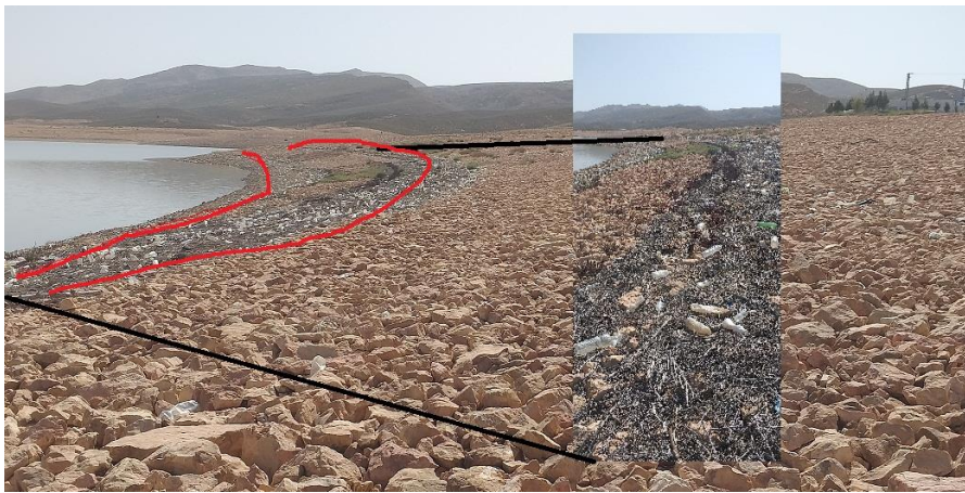
Figure 14. Ceinture pierreuse en amont du barrage sans couvert végétal avec deux marquages par dépôt de débris du à la diminution de la retenue en eau (Photo originale, 2021).
