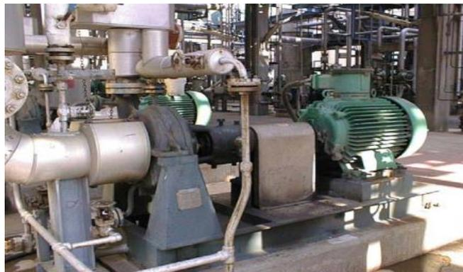
Figure I. 8 : Une pompe centrifuge de type Aspiration Axiale. [13]
