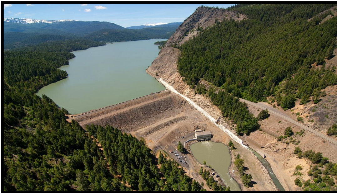
Photo II.05: barrage Tieton à Washington barrage en terre avec membrane en béton armée (USBR, 2012)
