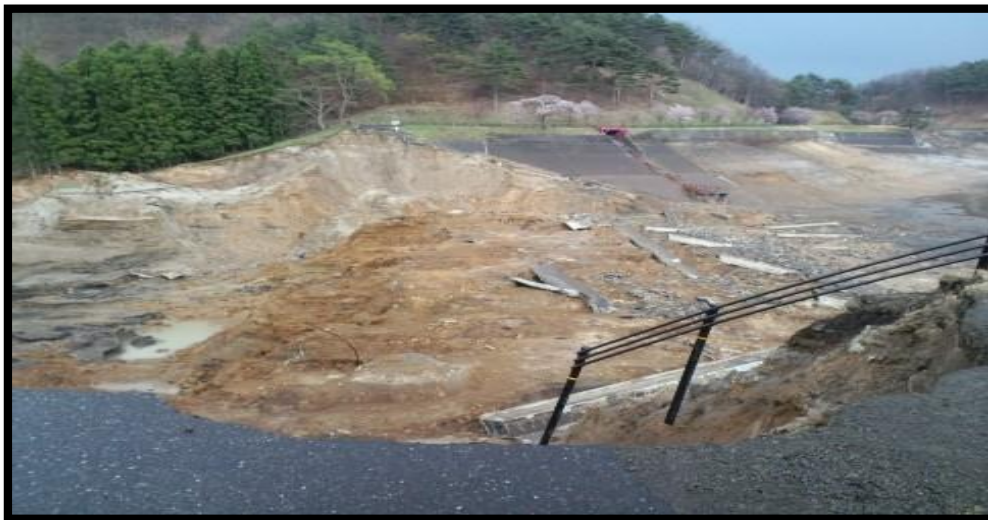
Photo III.12: la rupture du barrage Fujinuma pendant le séisme du japon 2011 (DAJ, 2011)
