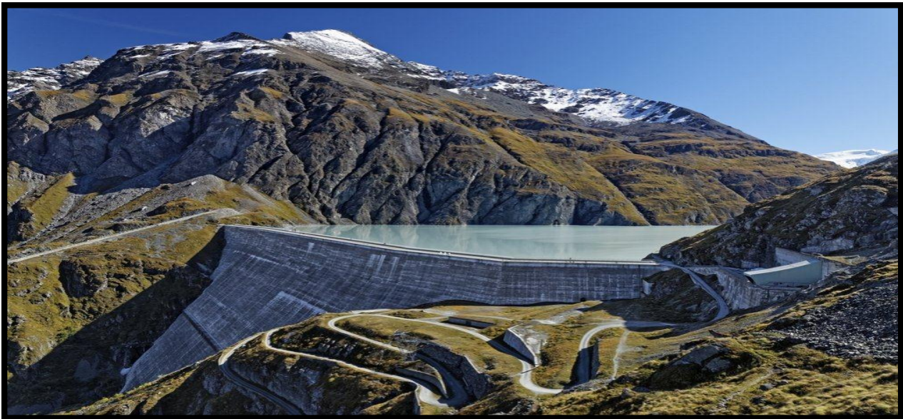
Photo I.03: barrage poids grande-Dixence en suisse le plus haut au monde 284m (Martinezbres)
