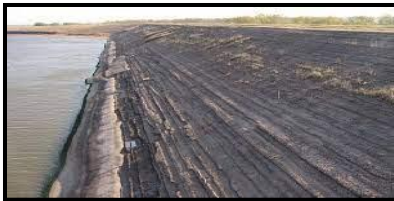
Photo IV.01: les méthodes de protection de la face amont (Google image)
