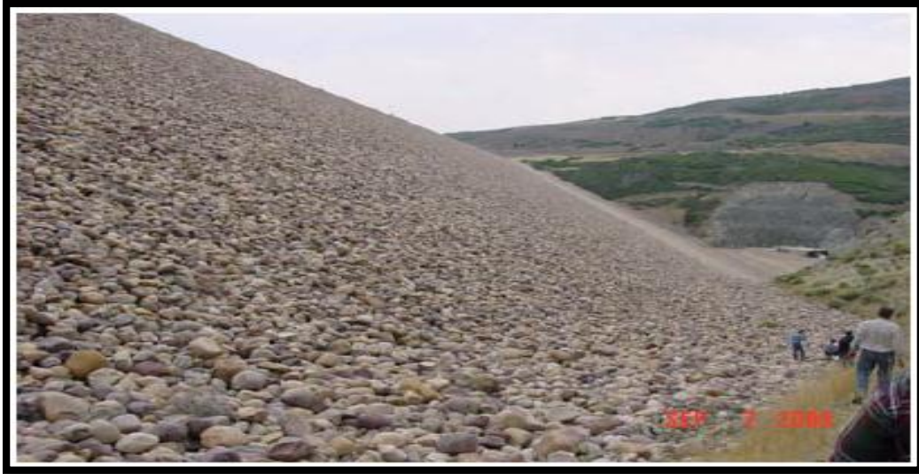
Photo IV.05: protection du talus aval avec des galets dans le barrage de Jordanelle, Utah, USA (USBR, 2012)
