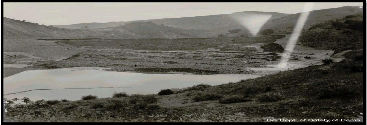
Photo III.10: glissement du talus amont du barrage Calaveras, California 1918 (UCDavies)
