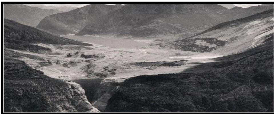
Photo III.11: barrage de Vajont après le glissement de terrain (CFBR, 2012)
