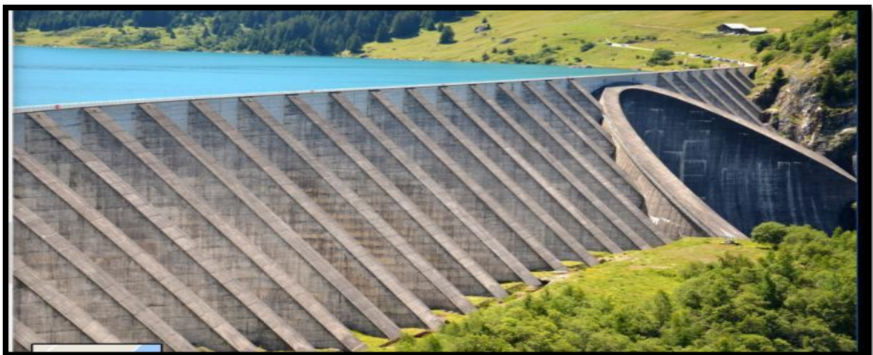
Photo I.05: vue générale du barrage Roselend France (geosoc.fr)
