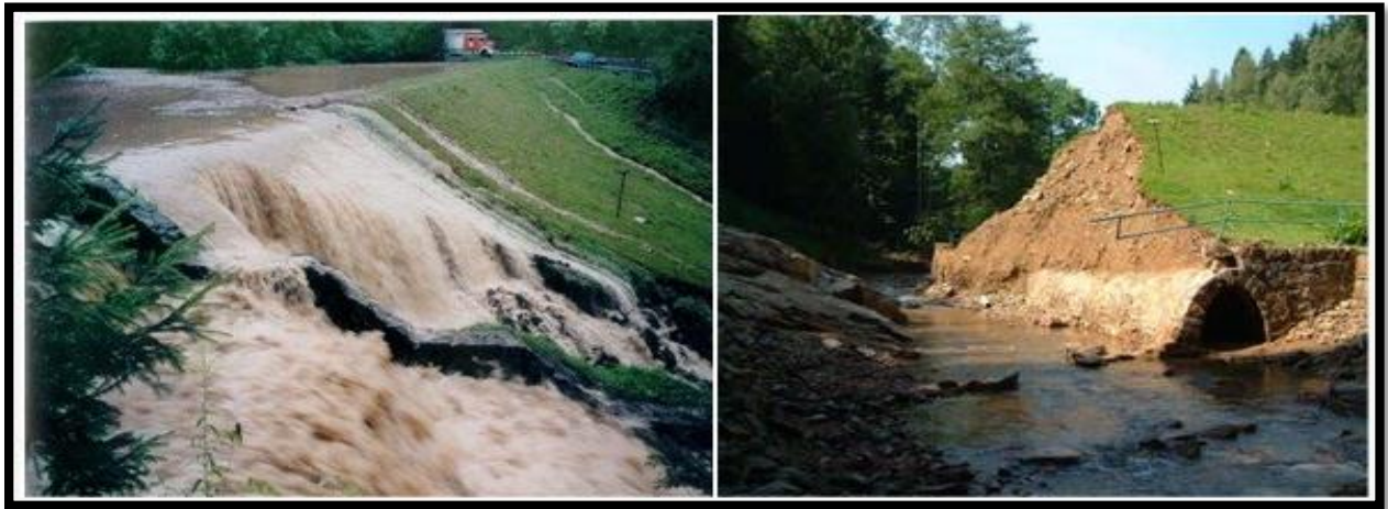
Photo III.01: la rupture du barrage Glashutte- Allemagne par submersion (ASDSO)
