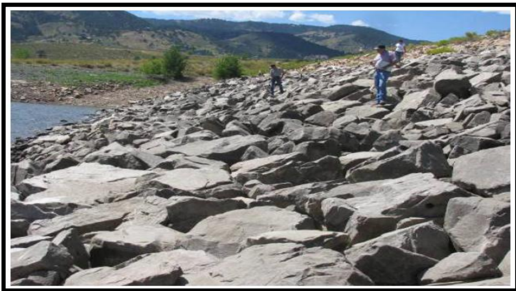
Photo IV.02: le rip-rap dans le talus amont du barrage horsetooth Colorado, USA (USB, 2012)
