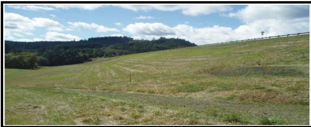
Photo IV.06: protection végétale du talus aval du barrage de scoggins, Oregon (USBR, 2012)
