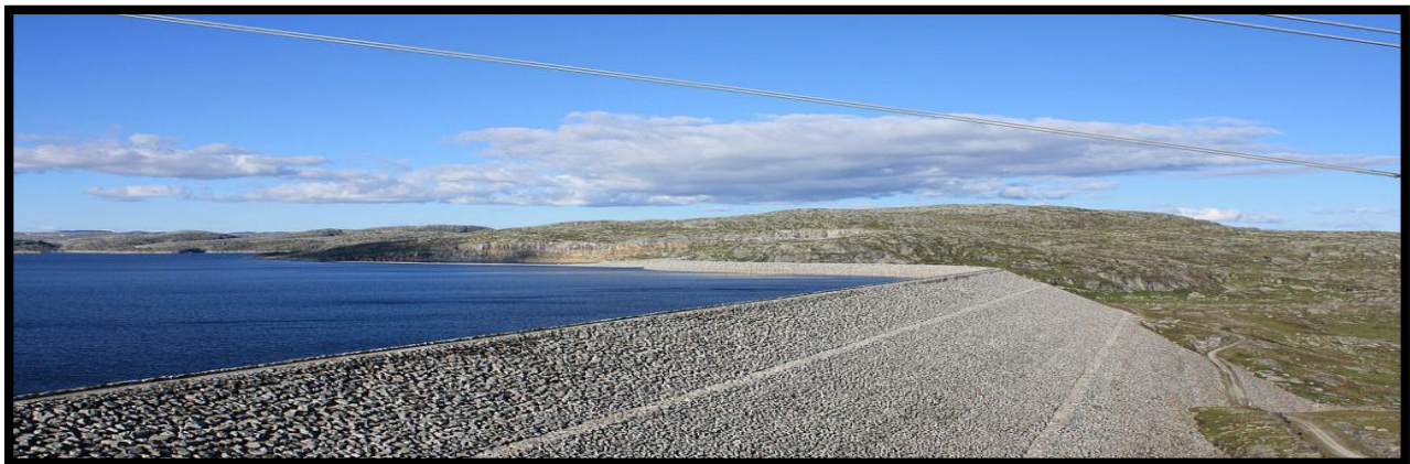
Photo II.06: barrage en enrochement Ulla-Forre, Norvège (Martin NH)
