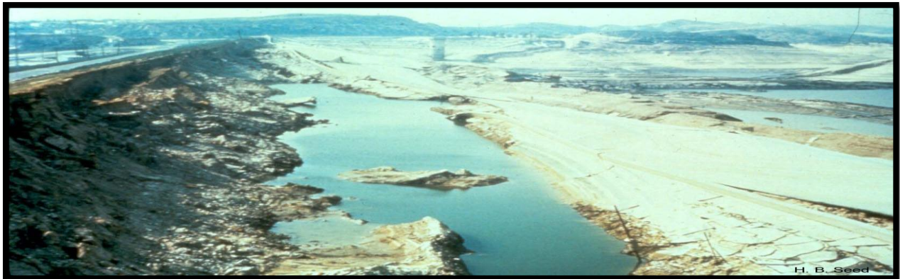
Photo III.14: rupture du barrage San Fernando, California par liquéfaction pendant le séisme de 1971 (UCDavies)
