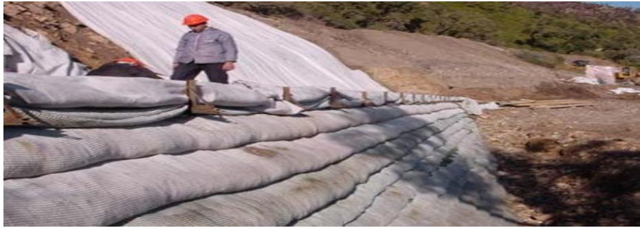
Figure 3.7 Parement préfabriqué devant le massif en géotextile (service d'étude technique des routes et autoroutes(SETRA)).
