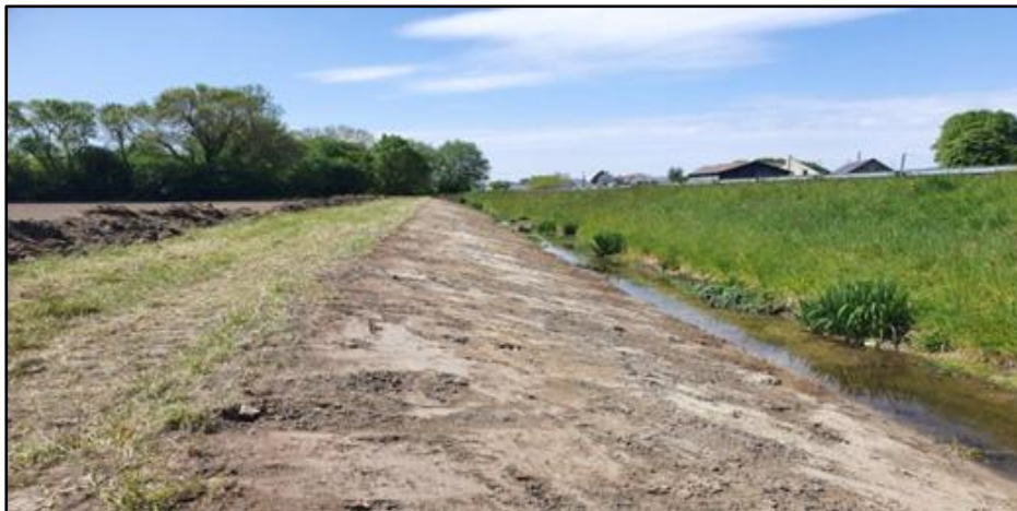
Figure 3.3 Retalutage des berges du ruisseau de l'Étang
