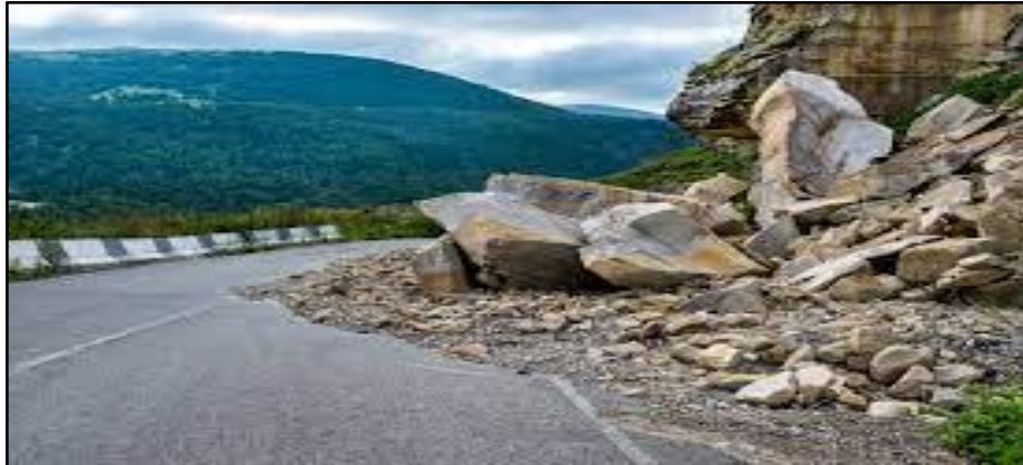
Figure 1.9 Chute de pierres
