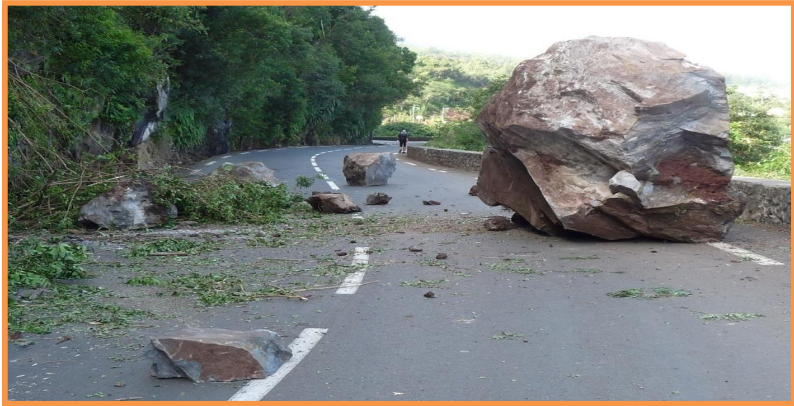
Figure 20 : Une photo que représente chute de blocs – BRGM -
