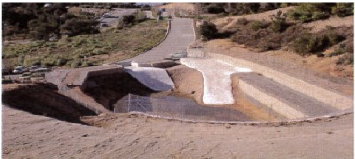
Figure49 : bassin de rétention à l'air libre
