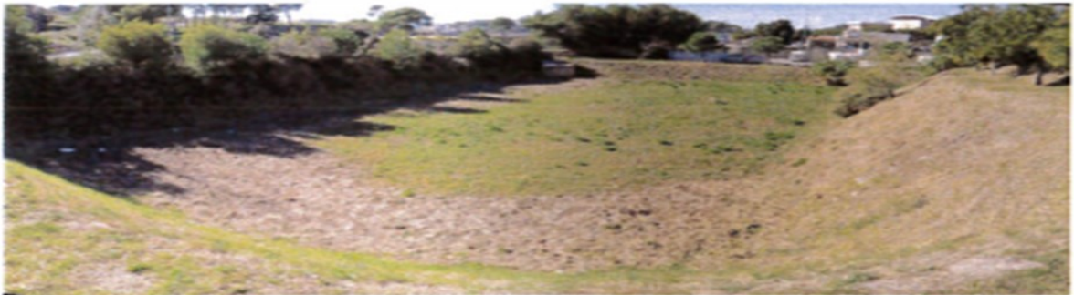
Figure48 : bassin de rétention à l'air libre
