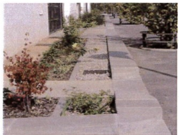
Figure53 : les façades des tranchées
