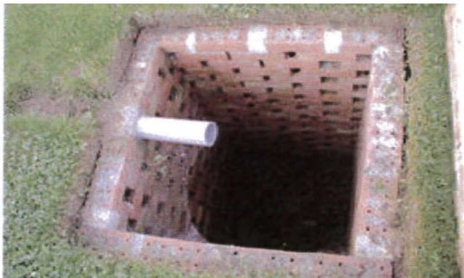
Figure 54 : les façades des puits d'infiltration
