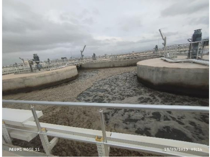
صورة رقم 09:مياه أتية من الحوض الترسيبي الأولي لحوض التهوية
