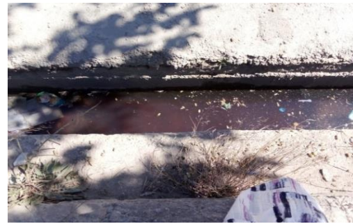
figure 46 : Route 1 er nov Tébessa
