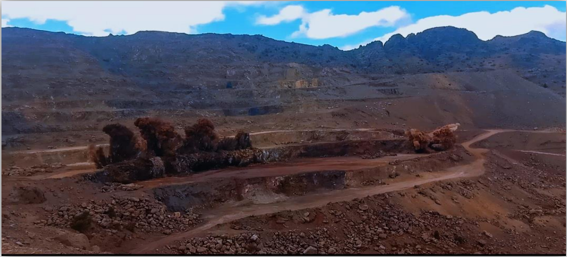
Figure 3.7. Travaux d'abatage de mine de l'Ouenza.
