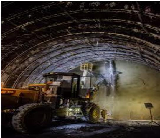
**Figure I.8** : Béton projeté seul [2]
