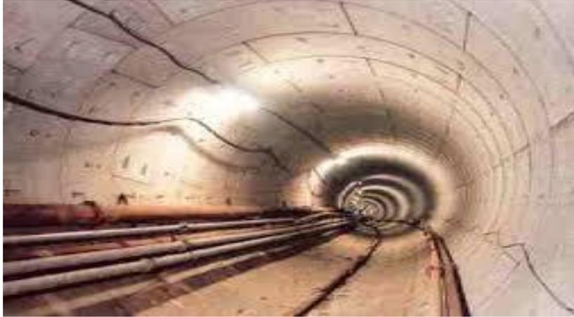
**Figure I.22** : revêtement par voussoirs en béton. [10]
