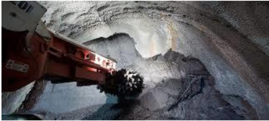
**Figure I.4** : Machine à attaque ponctuelle. [2]
