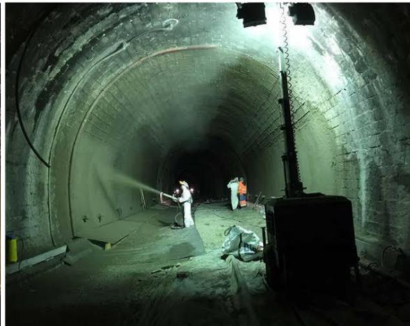
**Figure I.9** : Béton projeté avec les cintres [2]
