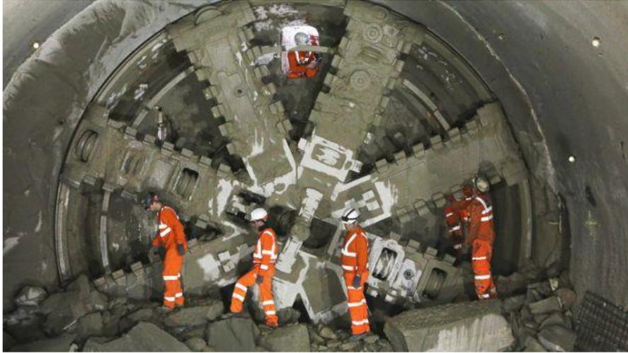
**Figure I.5 :** Creusement au tunnelier [2]
