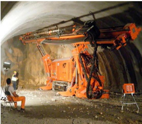
Figure I.12 : machine d'injection de Consolidation [2]
