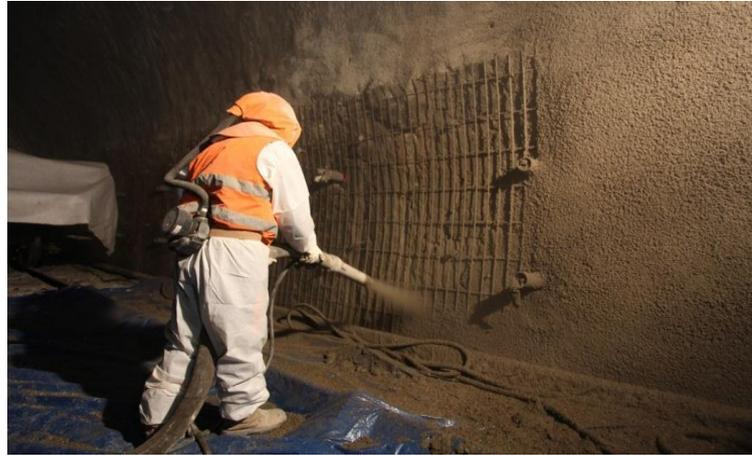
**FigureI.21** : Mise en œuvre du béton projeté. [9]
