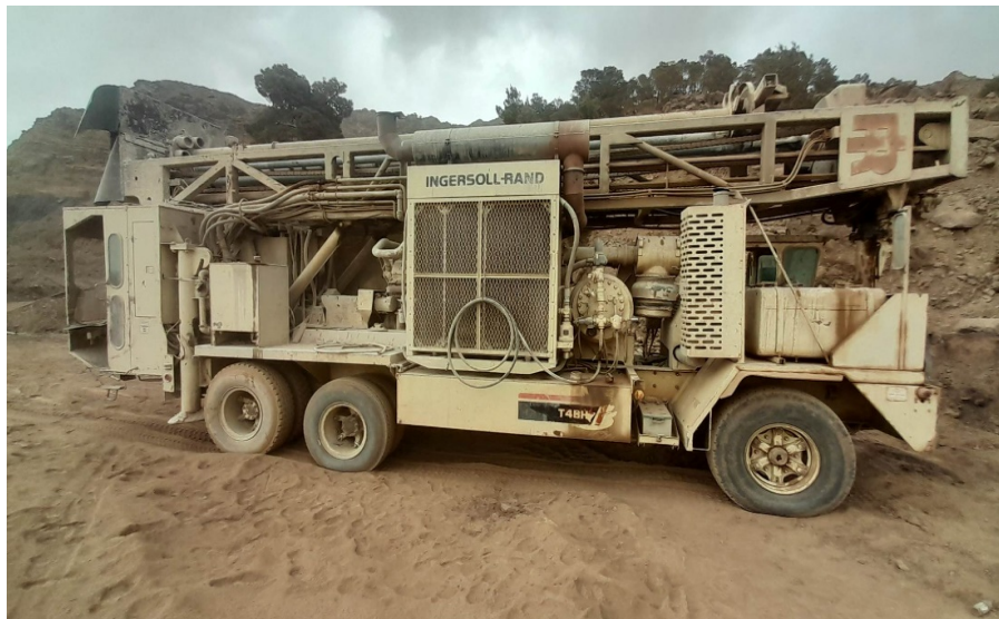
Figure II.9: La Sondeuse INGERSOLL - RAND T4BH utilisée pour les travaux de forage au niveau de la mine de Boukhadra
