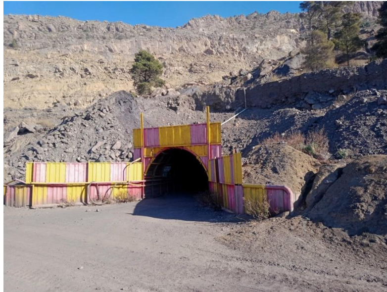
Figure III.6 L'entrée de la galerie 1045
