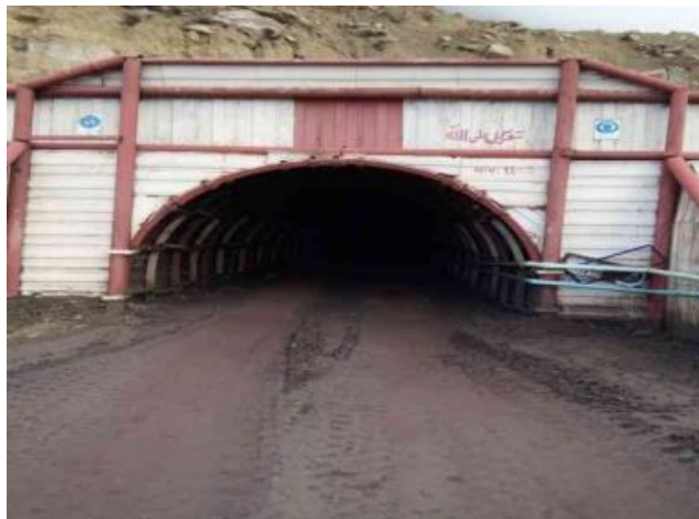
Figure II.10. Ouverture par galerie au jour, niveau 1105.
