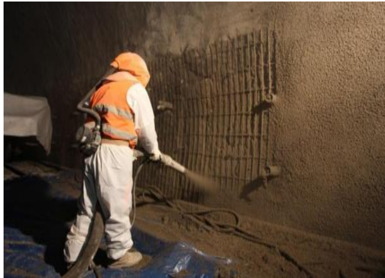
FigureI.27. Béton projeté [9].
