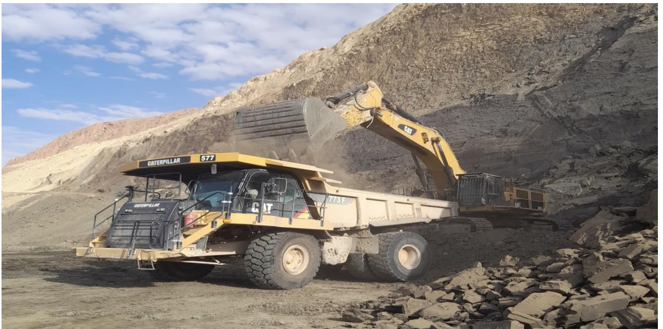
Figure III.7: L'opération de chargement d'un camion de marque CATERPILLAR 773F
