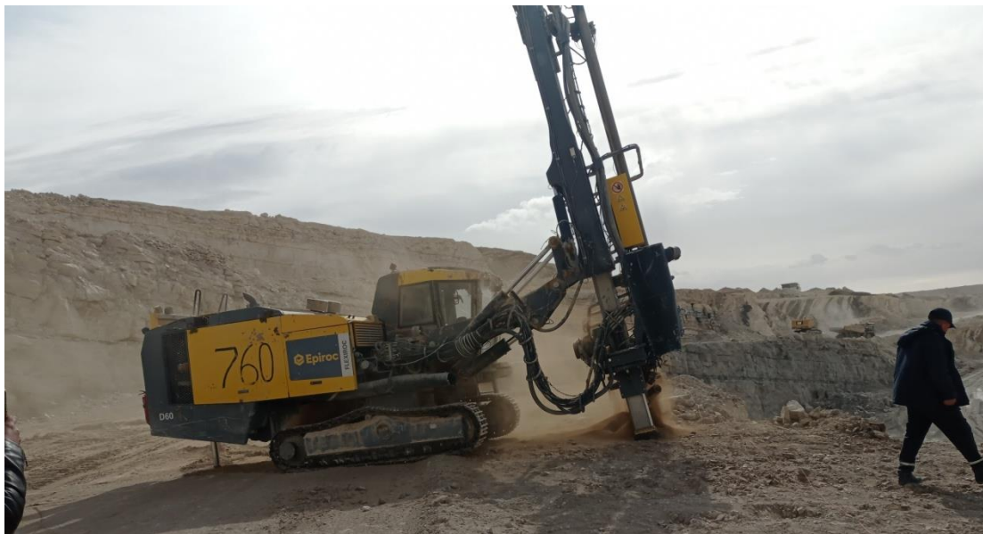
Figure V.7 : Sondeuse utilisée dans la carrière (Atlas Copco/ROC F6).
