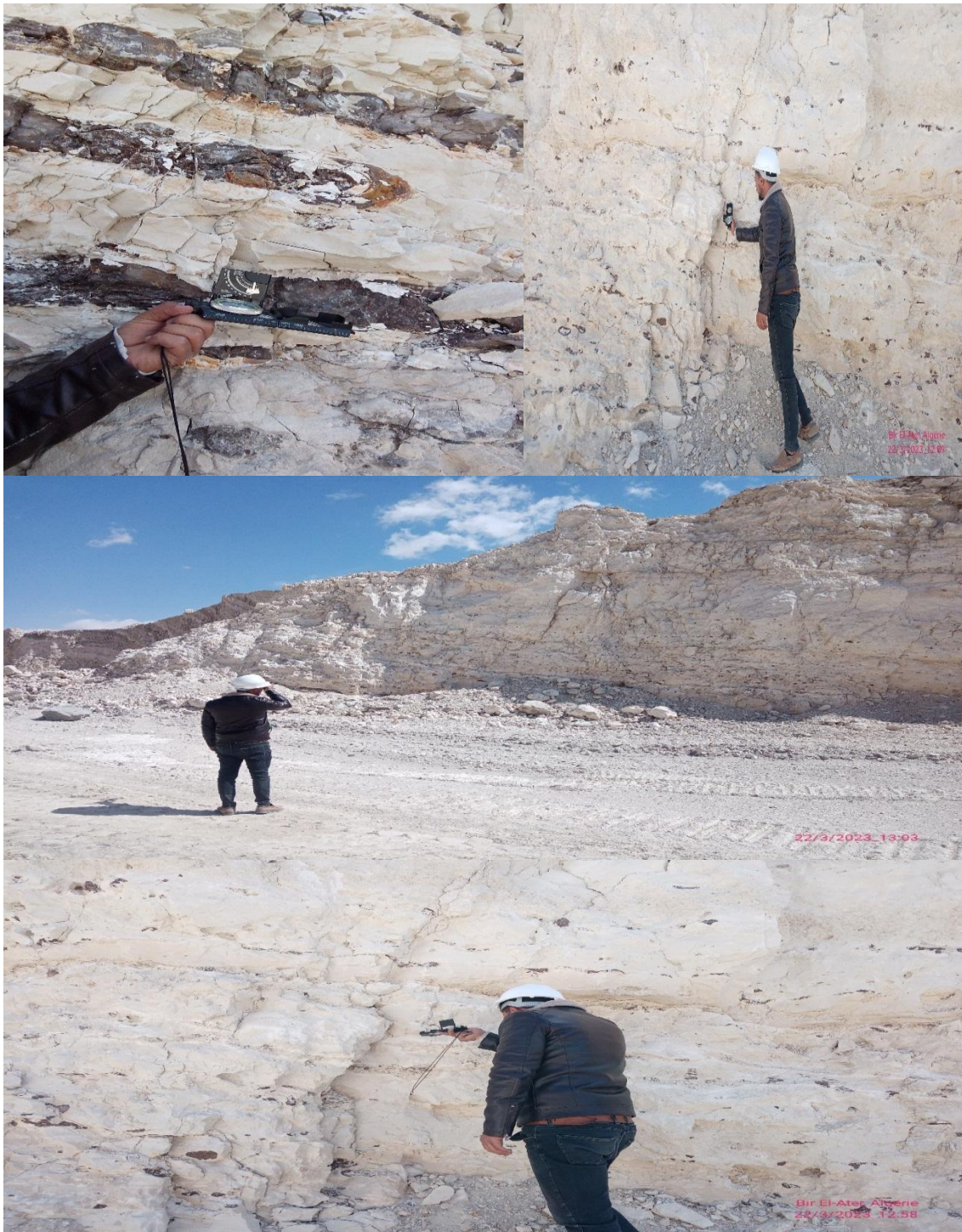
Figure 4.6 : Mesures d'orientation et de pendage des discontinuités in-situ.
