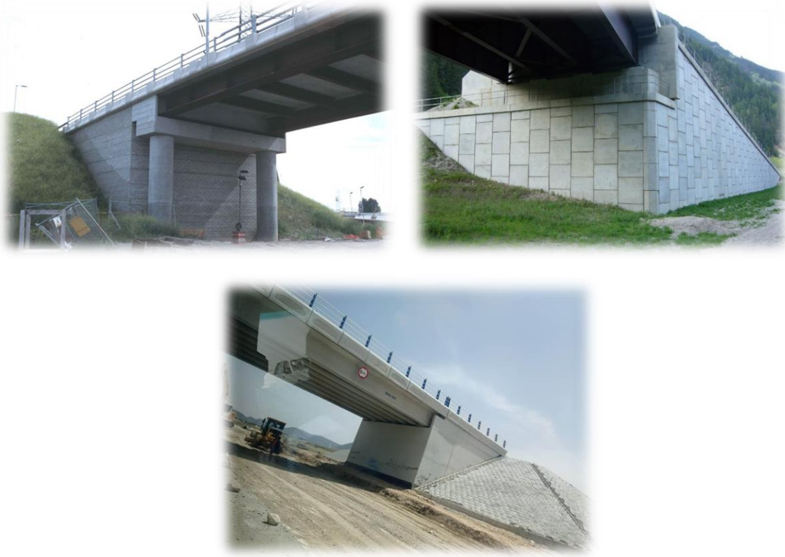
Figure 2.8 : Culée de pont
