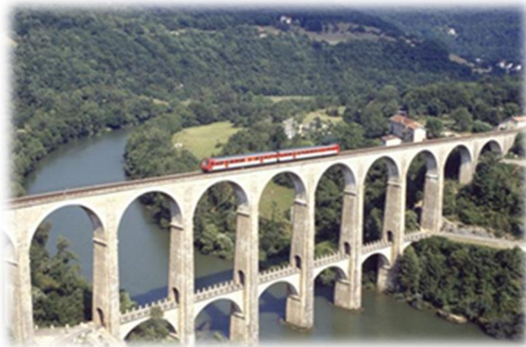
Figure 2.4: Les viaducs ferroviaires en France
