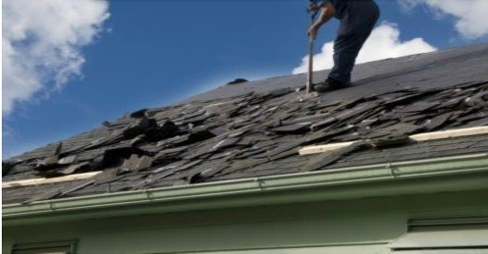
**Figure II.14.** Recyclage de bardeaux d'asphalte
