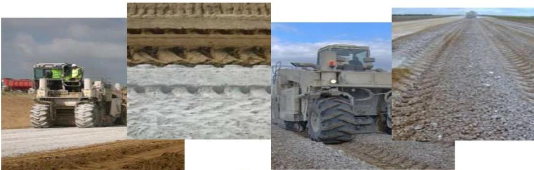
Figure III.2. Sol avant traitement *et* après traitement
