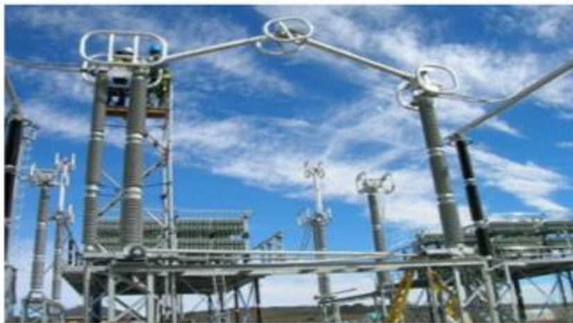
Figure 1.14 Sectionneur
