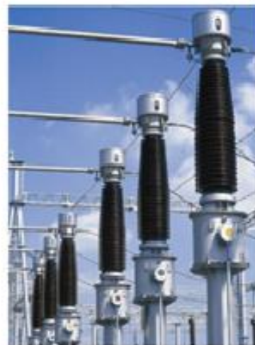
(b) Transformateur de tension
