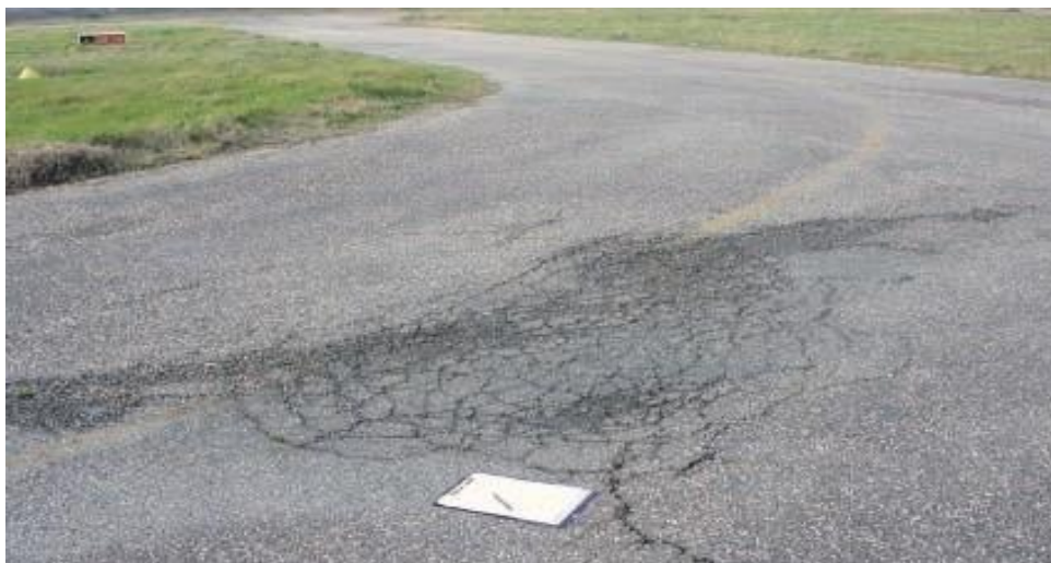
Figure 15 : 2.2.3 Faiëncage de fatigue (niveau de gravité moyen)(STAC,2007).
