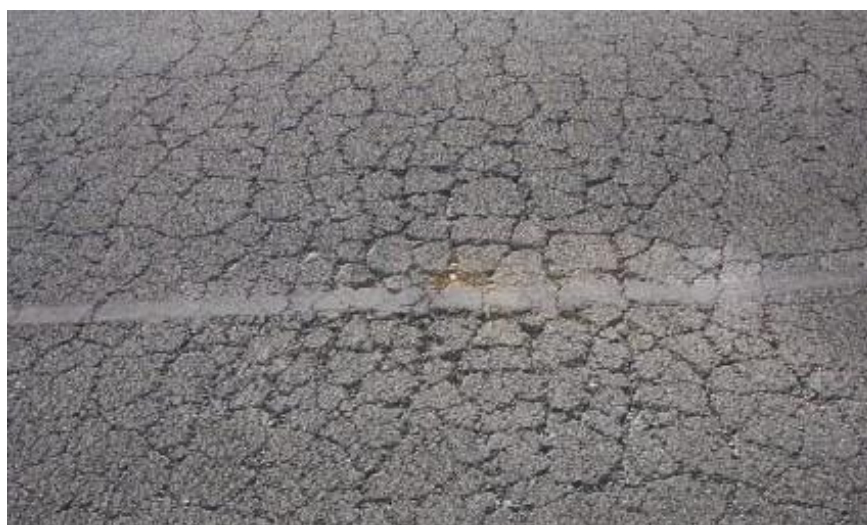
Figure 15 : 2.2.3 Faiëncage de fatigue (niveau de gravité moyen)(STAC,2007).
