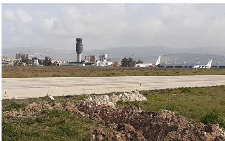
Figure 42 : 4.12 Tour de contrôle de l'aéroport
