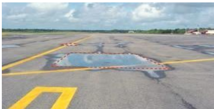
Figure 11 : 2.1.2 Flaches sur voie de circulation (STAC, 2007)
