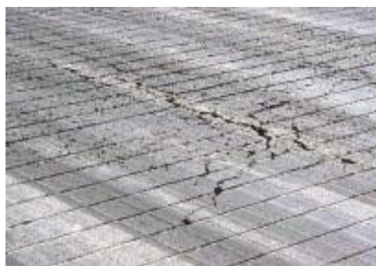
Figure 25 : 2.3.6 écaillage avec un niveau de gravité élevée
