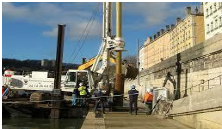
Figure 1.23 : Pieu foré tubé vibro-foncé. [14]
