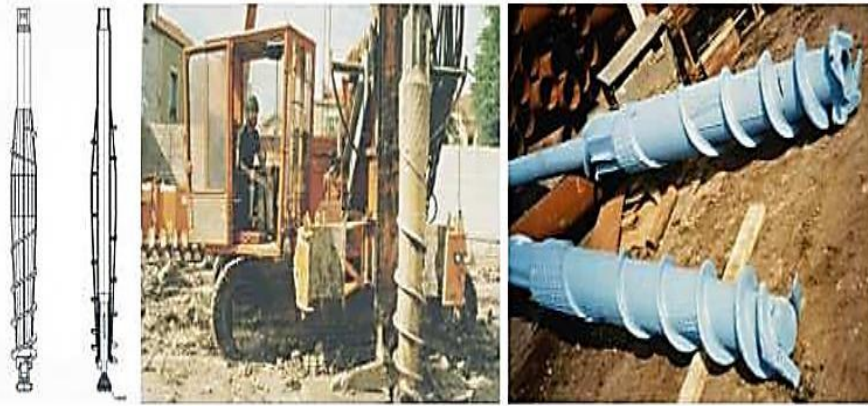
Figure 1.20 : Pieu vissé de type Oméga à deux pas de vis ou un seul. [5]
