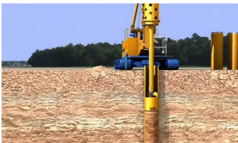
Figure 1.22 : Pieu foré à la boue. [13]
