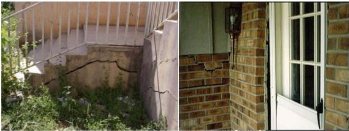
Figure 15: Les fissurations causés par le gonflant.
