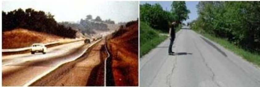
Figure 15: Les fissurations causés par le gonflant.
