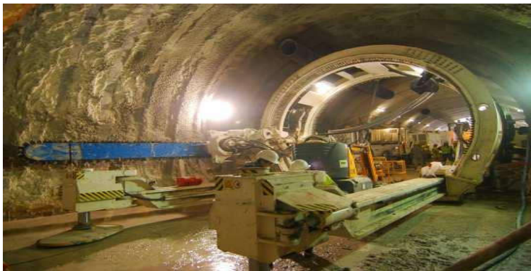
Figure II.9 Prédécoupage mécanique.
