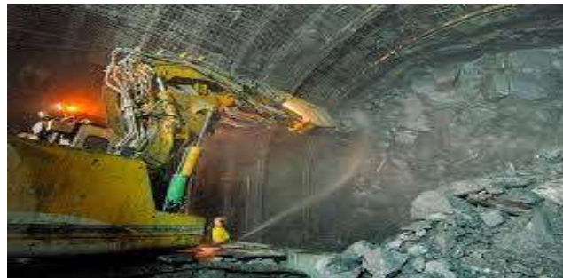
Figure II.1 excavation à l'explosif
