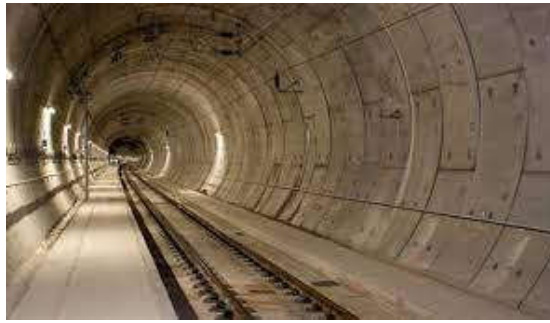
Figure III.7 Tunnel de forme circulaire.
