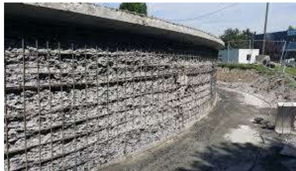
Figure II.3 Boulonnages associés à un treillis.
