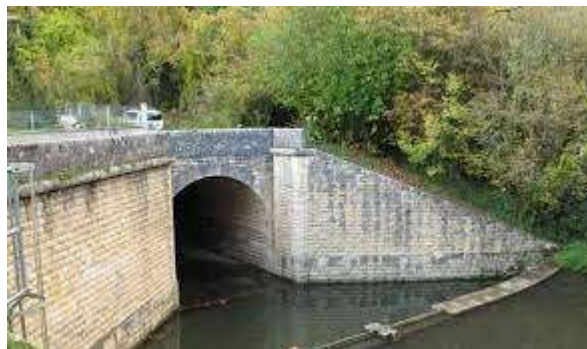
Figure III.16 Tunnel sous le lit de la rivière.
