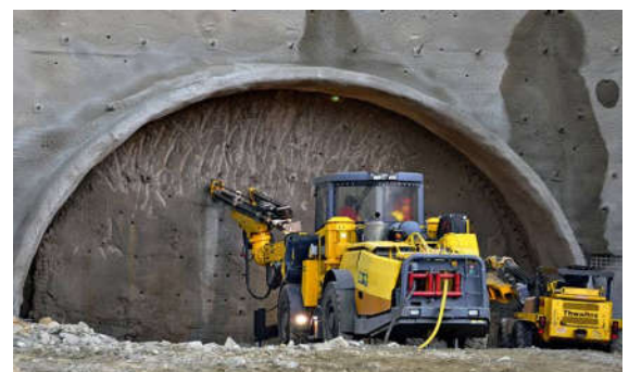
Figure III.19 Tunnelage par méthode NATM.
