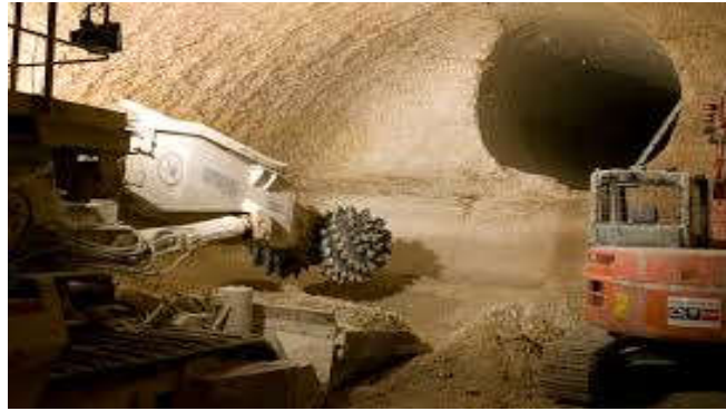
Figure II.7 Excavation par attaque ponctuelle.
