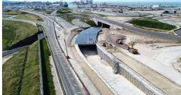
Figure III.15 Tunnel en tranchée ouverte.
