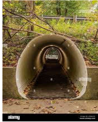
Figure III.12 Tunnel en forme d'œuf.
