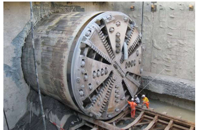
Figure III.18 Forage du tunnel avec voussoirs.
