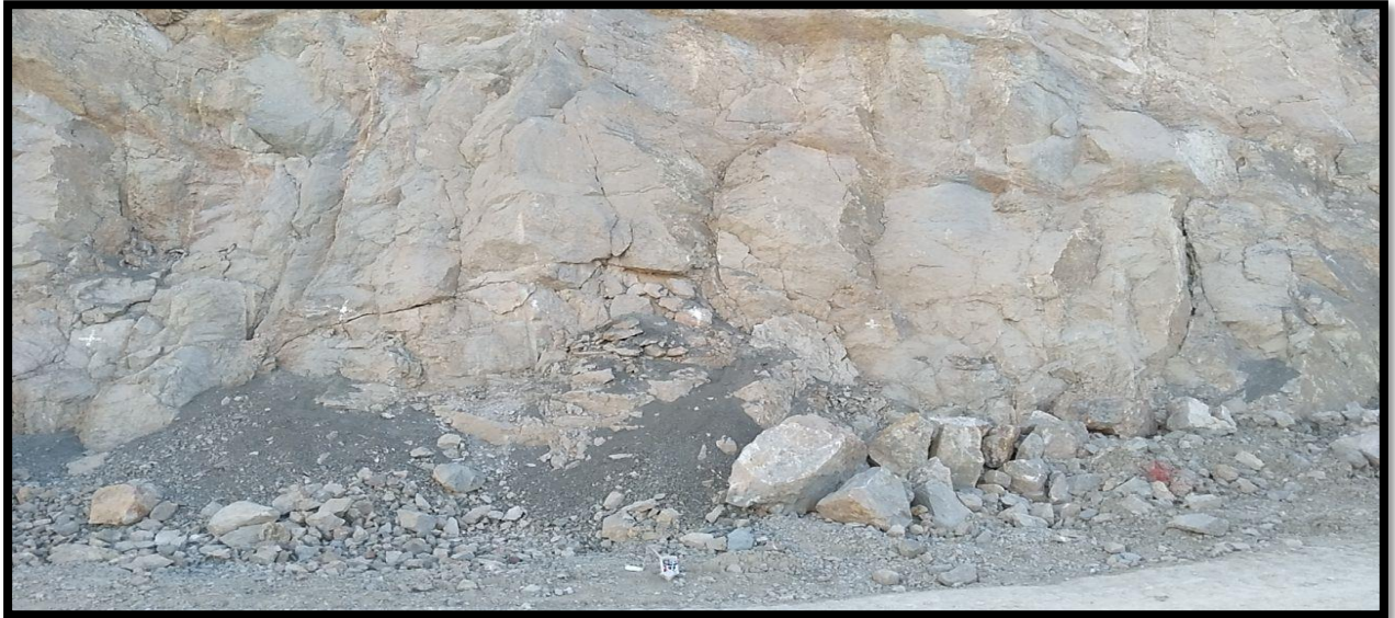
Figure. I.5 Structure géométrique du massif rocheux de calcaire (carrière Kef Dhbaa Morsot)
