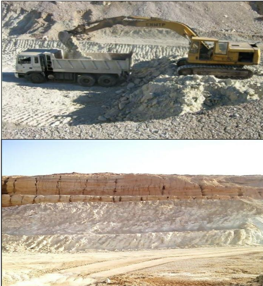
Figure 07 : Extraction bentonite et transport de tout-venant (carrière Roussel I).
