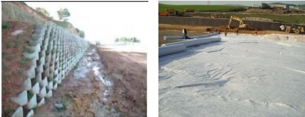
**Figure 3.6: Pose de géotextiles de renforcement (25)**
