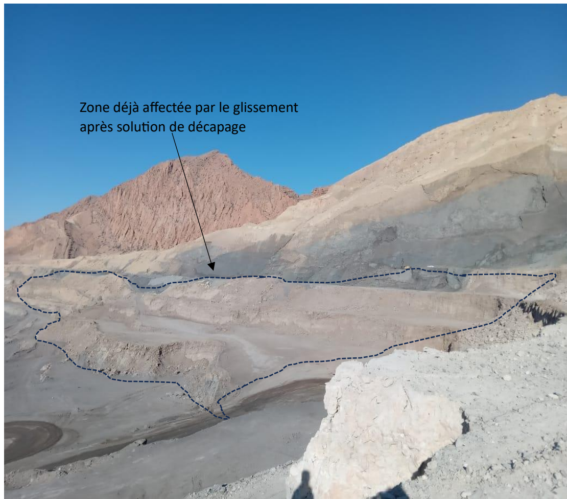
Figure - 35- l'état actuel de la nouvelle fosse nord-ouest de Kef-Essnoun après décapage de la masse glissée (photo du 02/2024).
