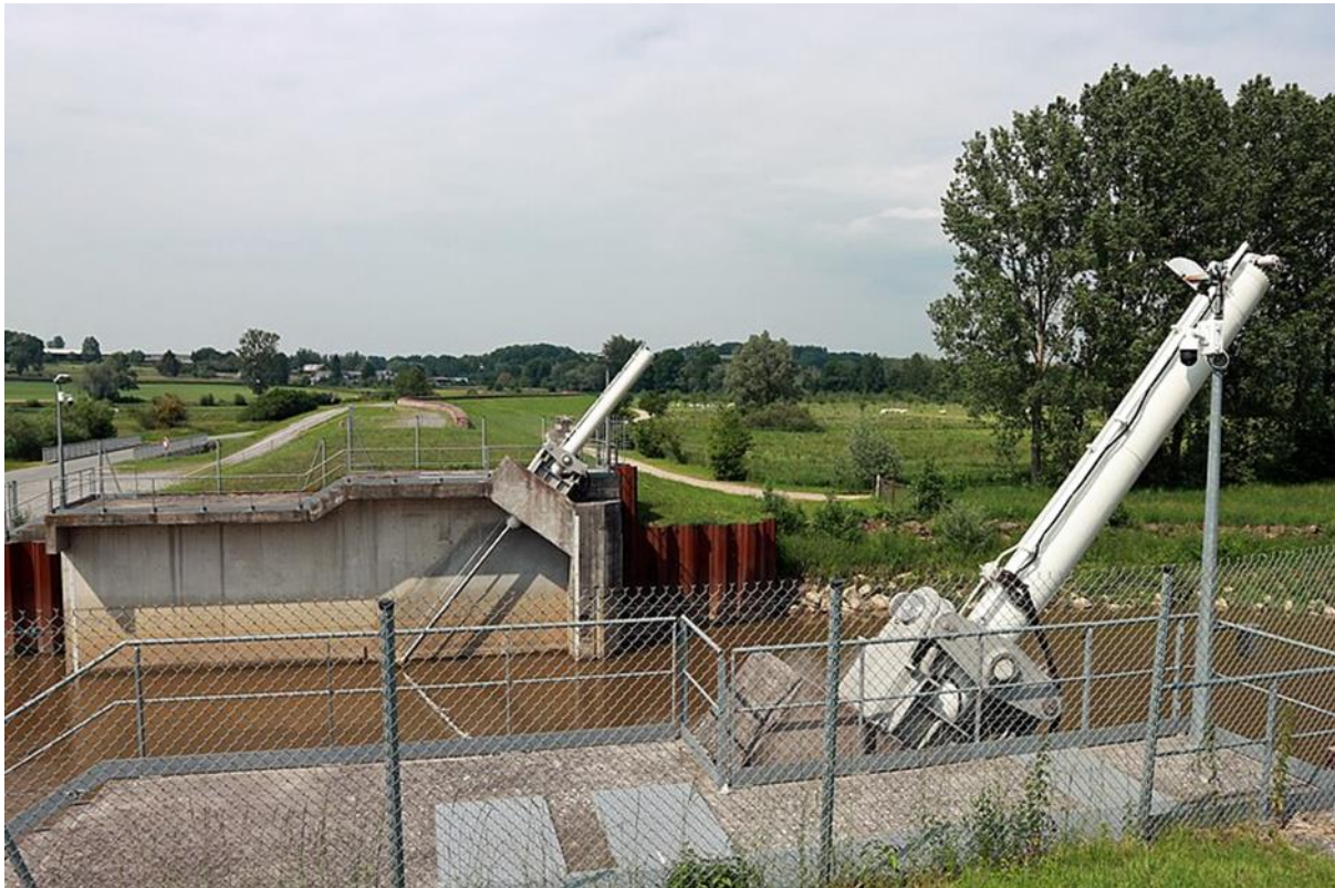
Fig.2 Barrage à pertuis vanné (wikhydro.developpement-durable).
