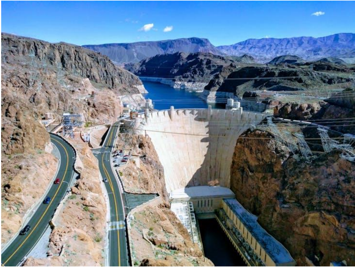
1. Fig.4 Barrage Hoover (États-Unis) (wikydro. developpement-durable).
