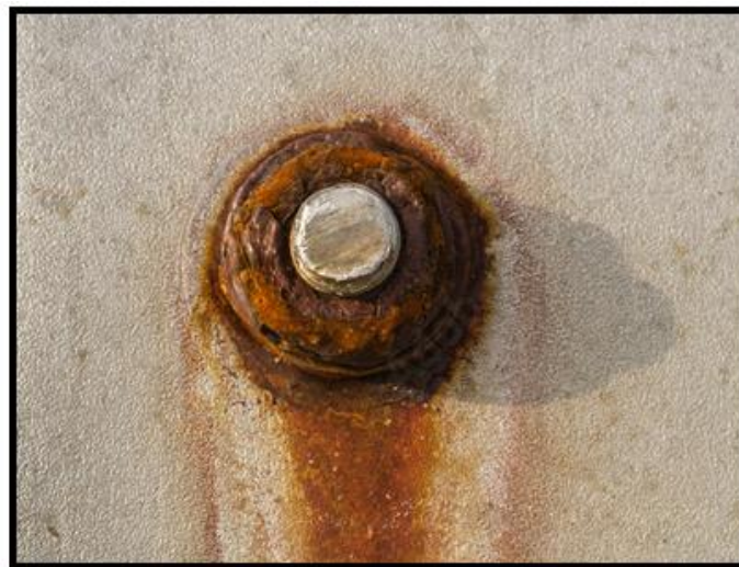
Figure I. 6 : Corrosion galvanique au niveau d'un boulon moins noble.
