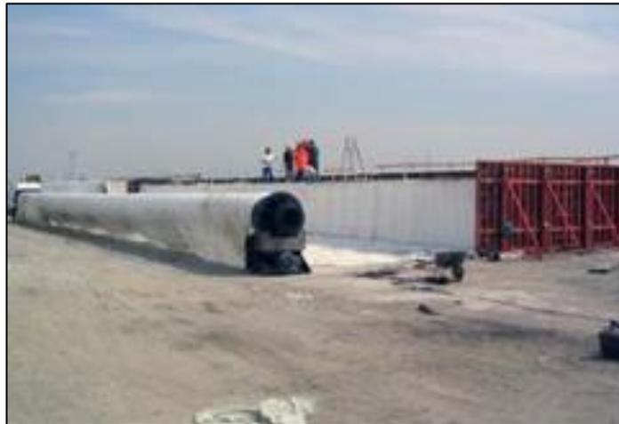
**Figure 1.26** *Fabrication à terre du parement en blocs de sable-ciment avec l'armature géotextile Geolon® PET200 de 100 m de long*
