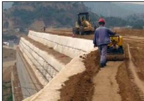
*Figure 1.30. Compactage du remblai armé près enroulée de la face du mur*
