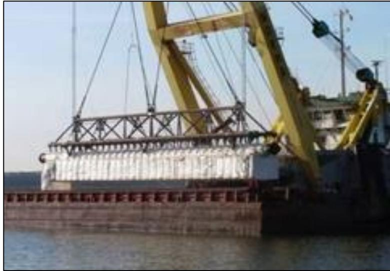
**Figure 1.25.** *Levage d'une unité de parement fabriquée avec une armature géotextile Geolon® PET200 attachée pour la mise en place sous l'eau*
