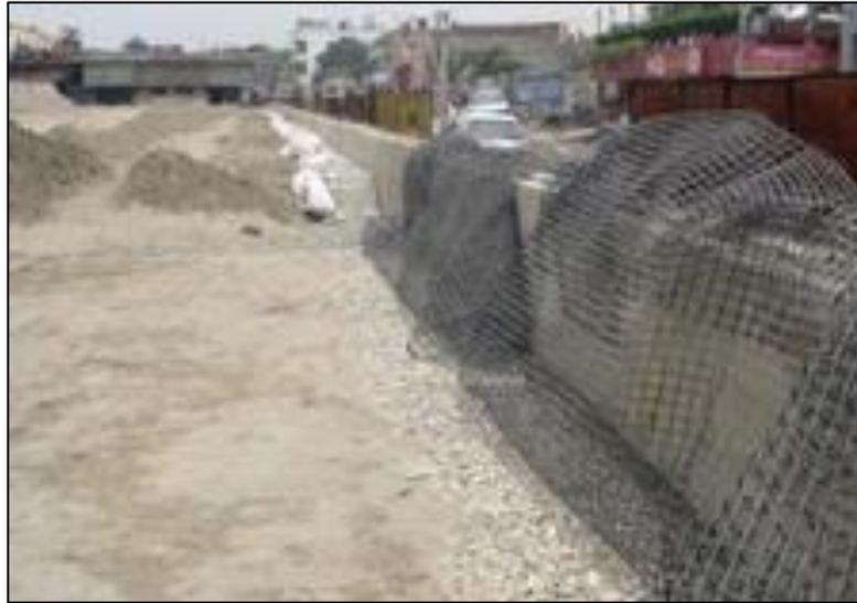
**Figure 1.22.** Couche de drainage granulaire avec filtre géotextile Polyfelt® TS30
