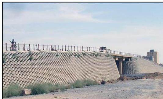
*Figure 1.20. Murs en blocs CT après l'achèvement des travaux*
