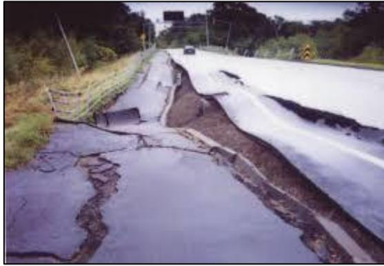
**Figure 2.1.** Rupture d'un massif renforcé.
