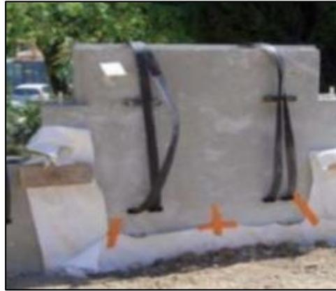
*Figure 1.10. Les renforcements géosynthétiques (système de connexion GeoMega)*
