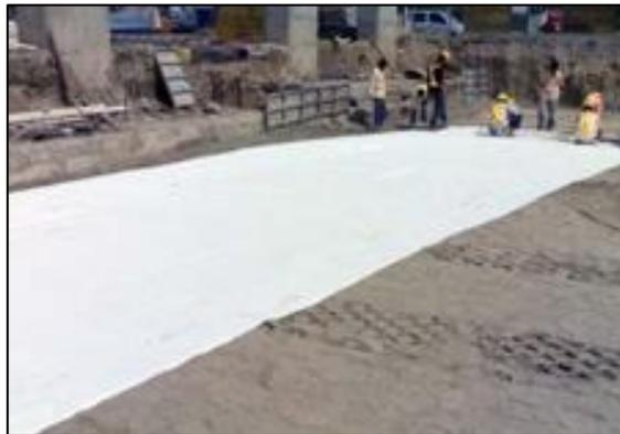
**Figure 1.21** Installation de l'armature géotextile Polyfelt® WX300 dans la plate-forme de sable compacté
