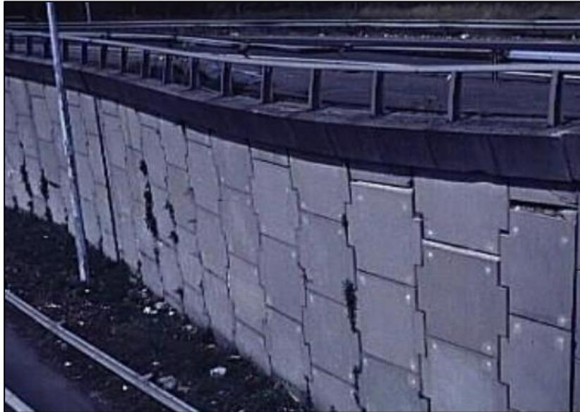
*Figure 3.5. Mauvais choix d'un type d'ouvrage au regard des tassements attendus
