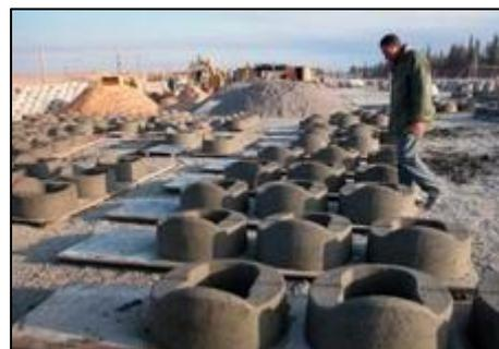
*Figure 1.18. Coulage des blocs segmentaires*
