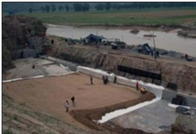
*Figure 1.28. Mise en place de la couche initiale de géotextile Mirafi® PET avec couverture de remblai renforcé*
