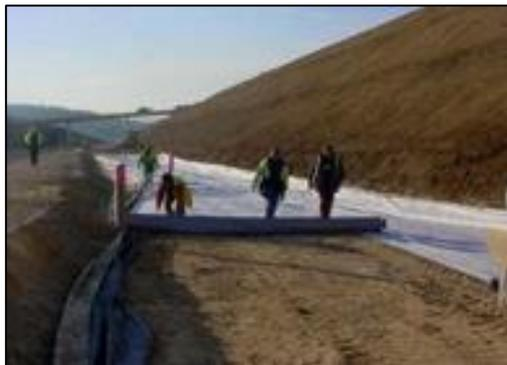
**Figure 1.13.** Mise en place du renforcement géocomposite Bidim® PPC75-75 le long de la base de la tranchée ferroviaire
