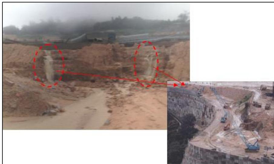
**Figure3.16.** Écoulement important depuis la plate-forme B entre les bacs à sable Arrière du mur R22 (Photographies prises vers 9h00)
