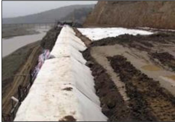
*Figure 1.29. Armature géotextile Mirafi® PET autour du parement du sac de terre.*
