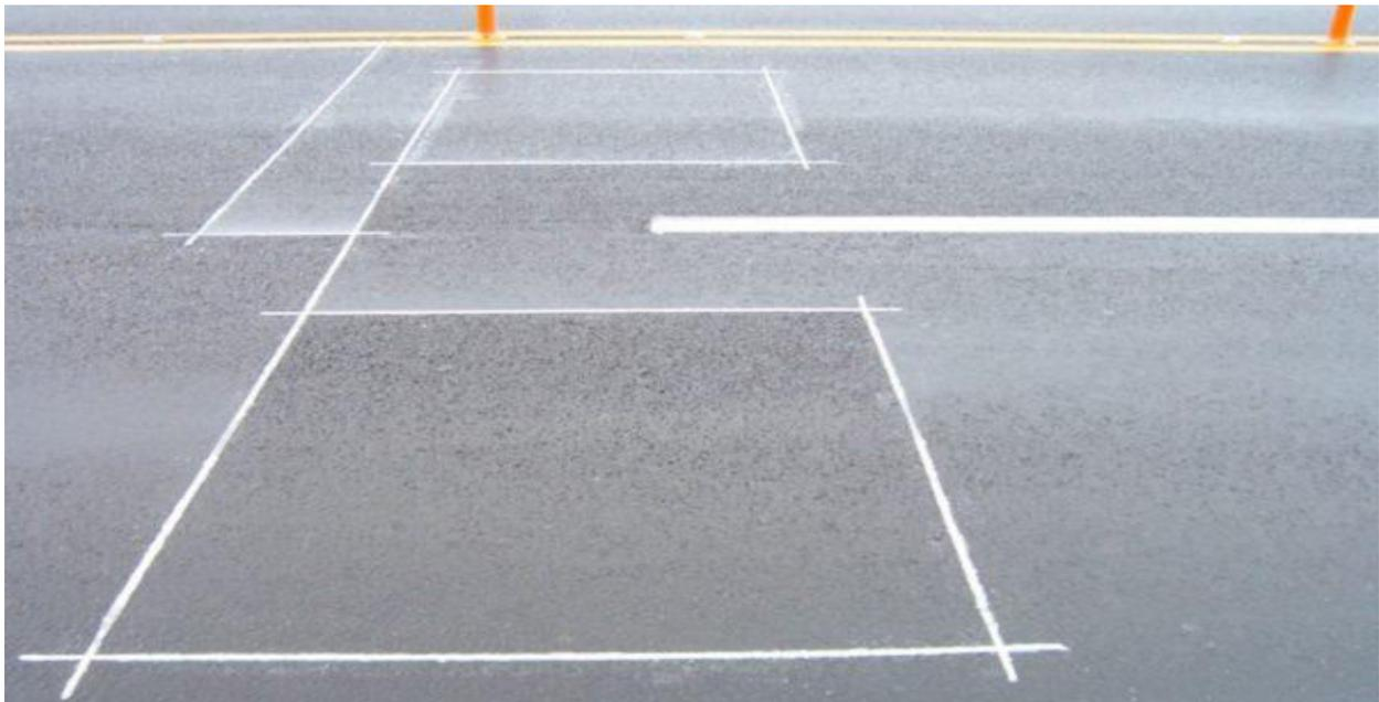
FIGURE 2.3 – Capteur de trafic Boucles inductives
