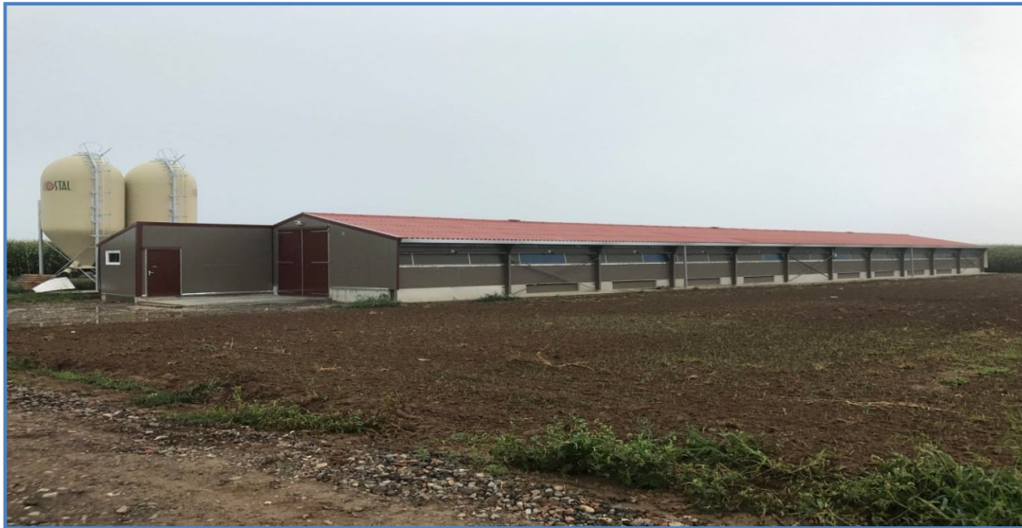
Figure 03: Bâtiment d'élevage de poulet de chair.
