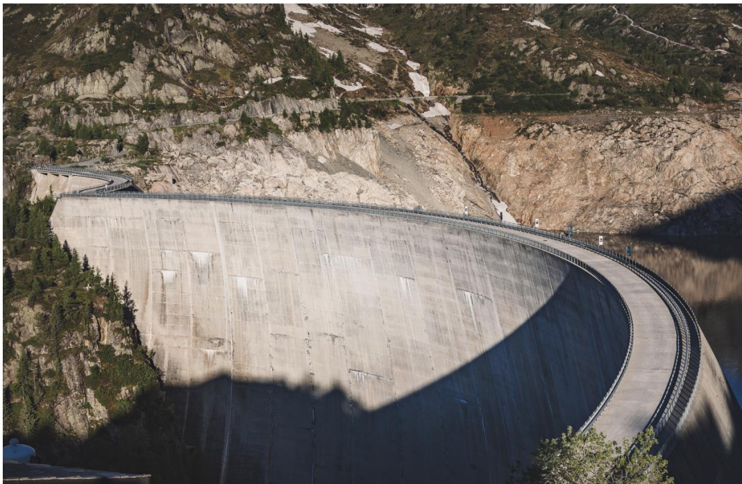
صورة رقم 1 سد خرساني مقوس في سويسرا (Switzerland Jochen Bückers)
