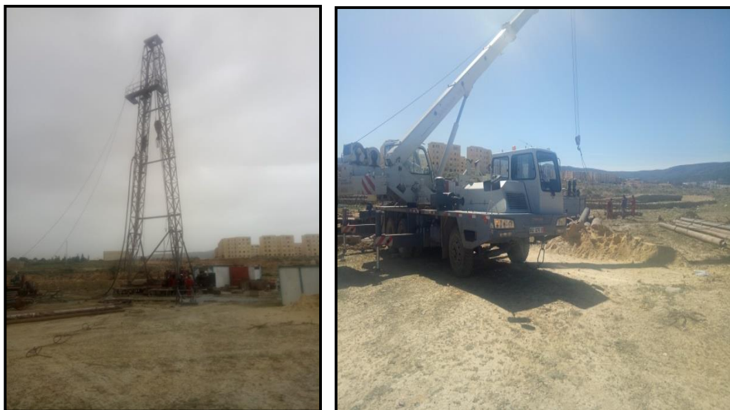
Fig. 46 : Transport et montage de l'appareil de forage/ installation du chantier P3.
