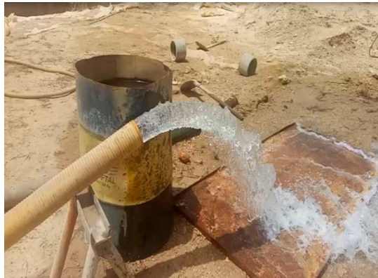
Fig. 54c : Essais de pompage par palier.
