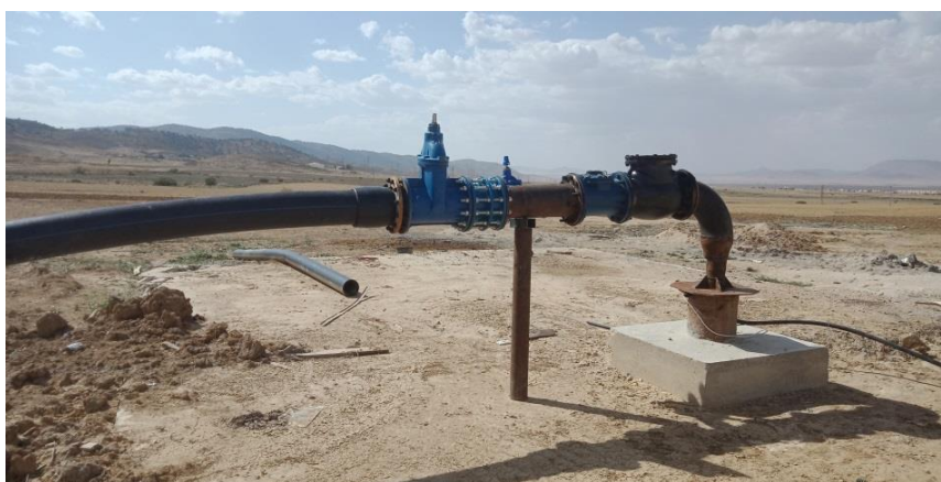
Fig. 50d : Équipement du forage P3 par les services de l'ADE. Le 18/07/2018.
