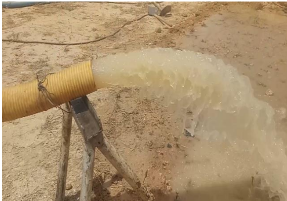
Fig. 54b : Développement du forage P2 à la pompe.
