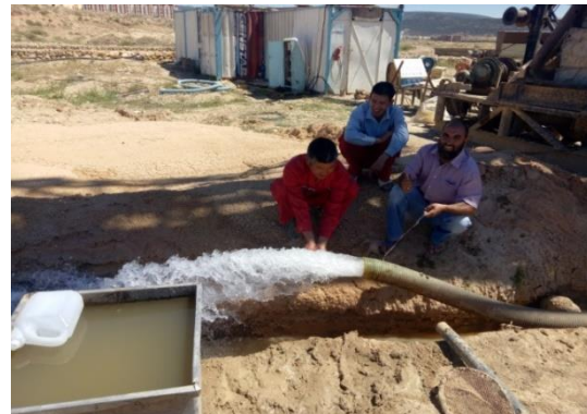
Fig. 50c : Essais de pompage par palier. Le 08/06/2018
