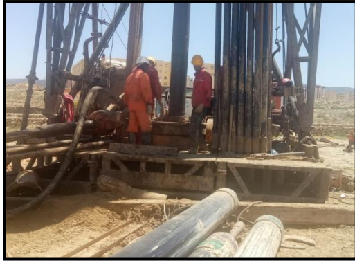
Fig. 47b : La descente de tubage API 9 1/2 ". Le 02/06/2018
