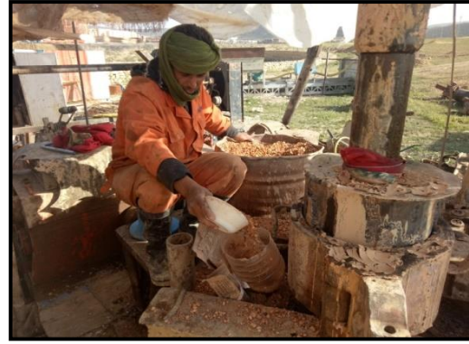
Fig. 47c : Mise en place du gravier. Le 03/06/2018
