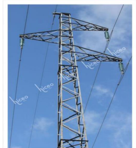
Pylône à trois triangles
