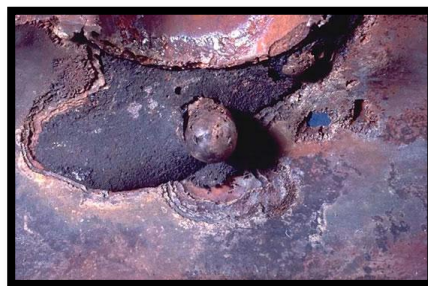
Figure- I. 3 corrosion galvanique
