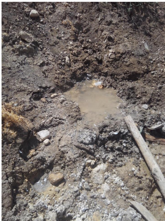
Photo : Nappe au niveau de la semelle (3m) au Mois d'Aout dans le site d'El Kherba.
