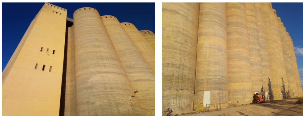
Figure 5. Silos en béton CCLS–Tébessa (complexe El-Laouinet (photo personnelle))
