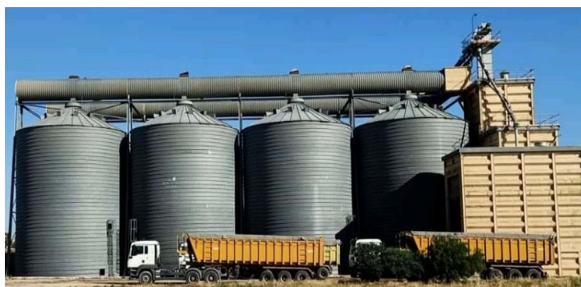
Figure 4. Silos métallique (CCLS de Tébessa) (photo personnelle)
