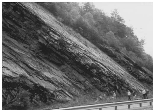
**Figure III.6** Rupture plane sur un joint stratigraphique lisse et persistant (Interstate 40, near Newport, Tennessee).
