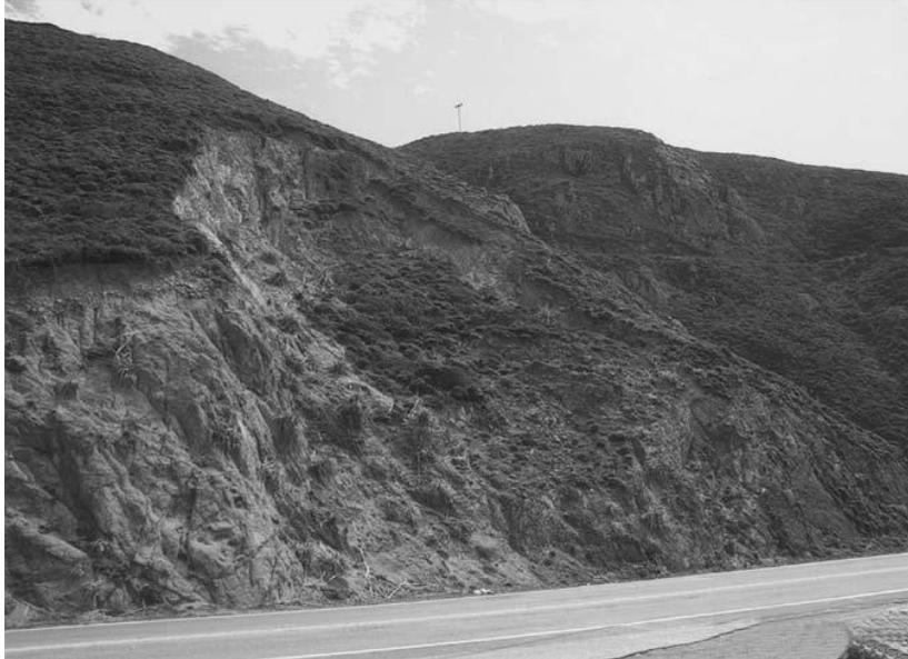
**Figure III.13.** Rupture circulaire dans des granites fortement altérés (Highway 1, near Devil's Slide, Pacifica, California).
