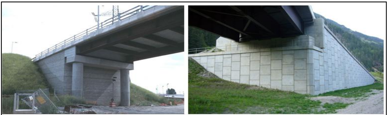
Figure 3.2. Culée de pont
