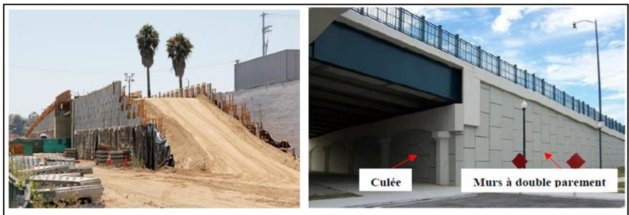
Figure 3.6. Construction de murs à double parement
