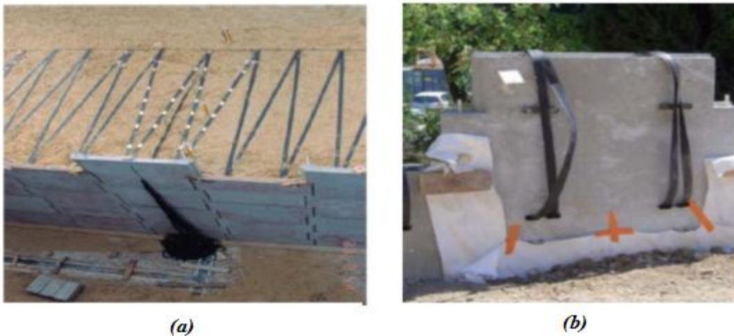
Figure 2.4. Les renforcements géosynthétiques : (a) système Freyssisol, (b) système de connexion GeoMega
