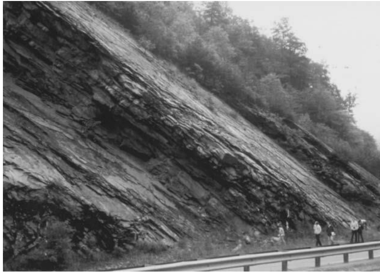
Figure 10: Photo montrant un glissement planaire
