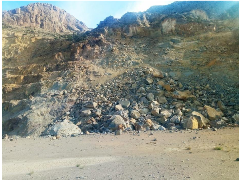
Figure 17: Photo montrant les gradins instables BK2, de la mine de Boukhadra.
