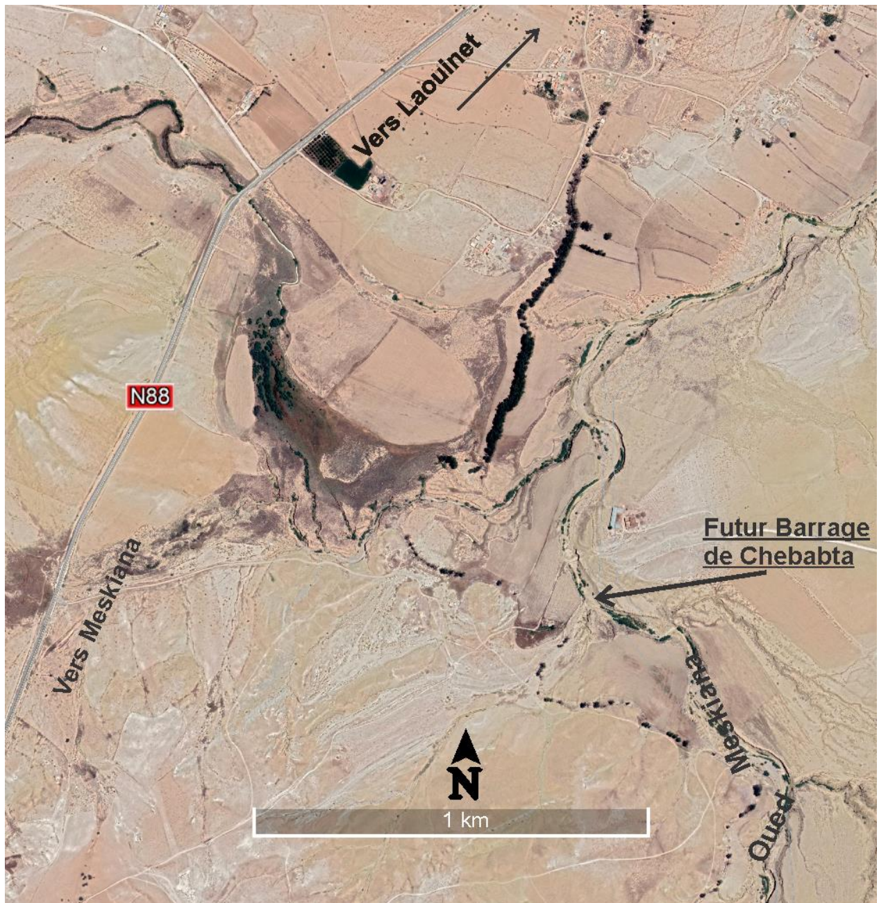
Figure 1 : Localisation du barrage de Chebabta sur Google Earth 2020
