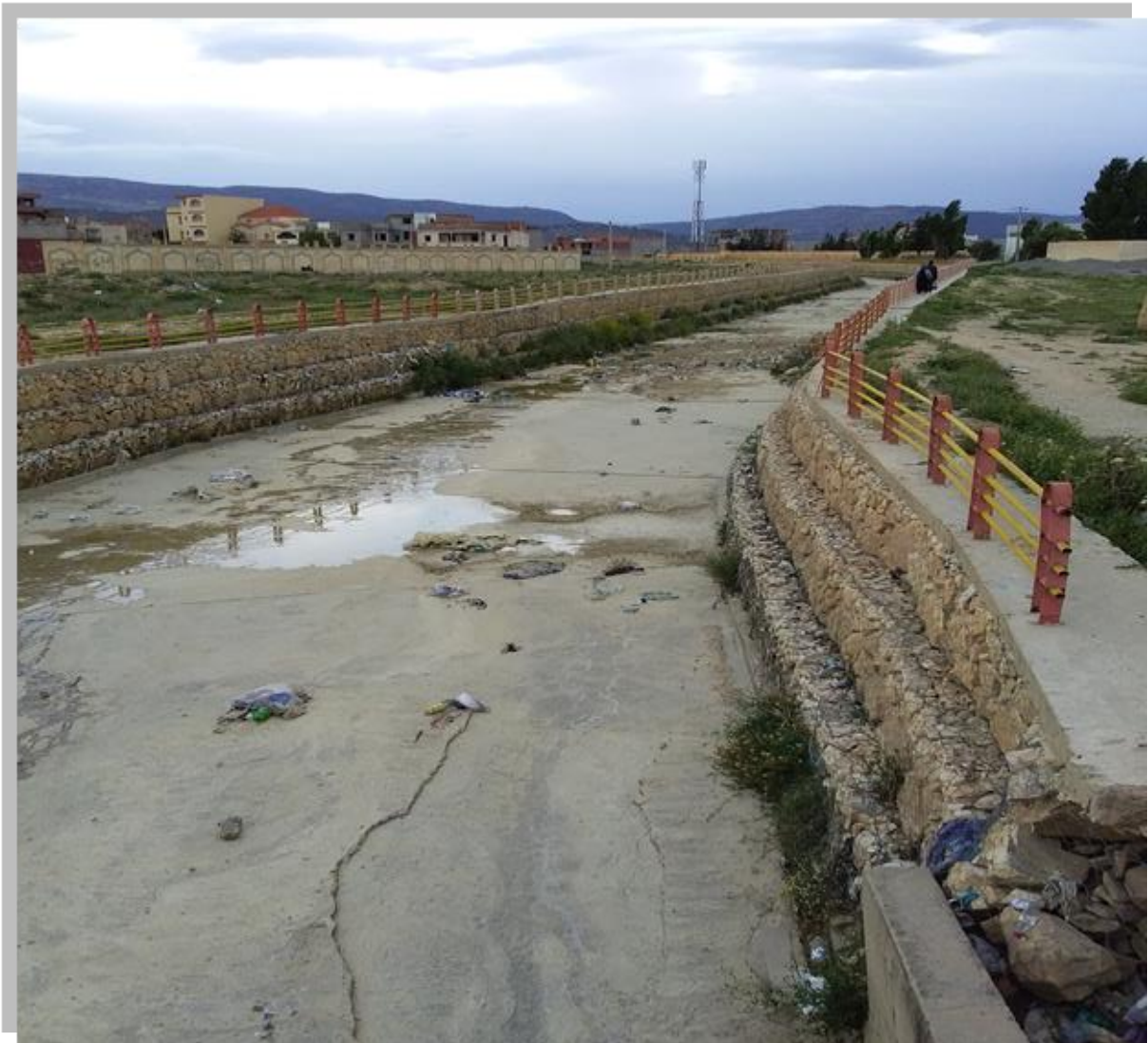
Figure 33 : Enrochement à Thuir (La trencade - France). (Boulghobra ,2006)
