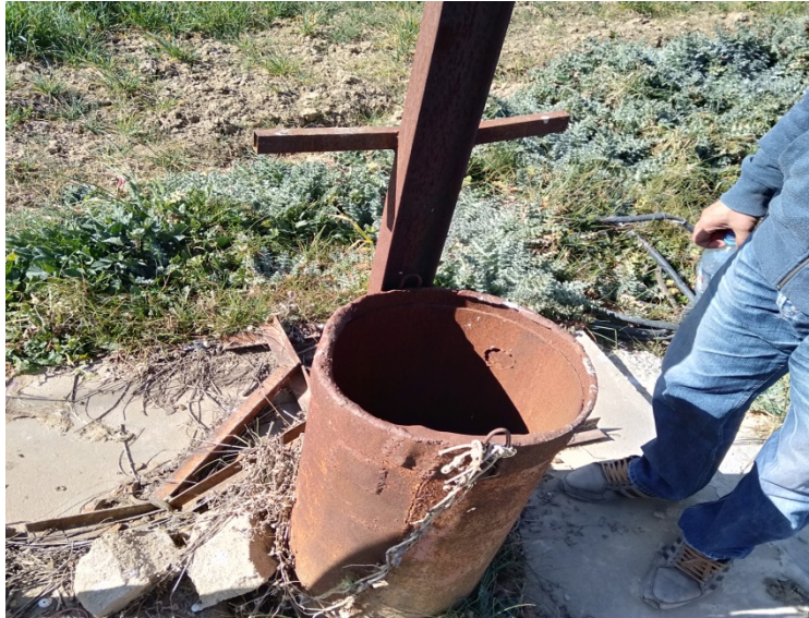
Forage abandonné à cause de salinité a profondeur de 70m.
