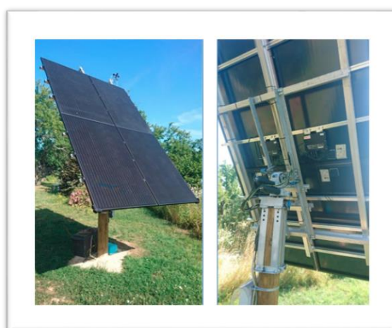
Figure 25 : Suiveur solaire Sunny-Watt
