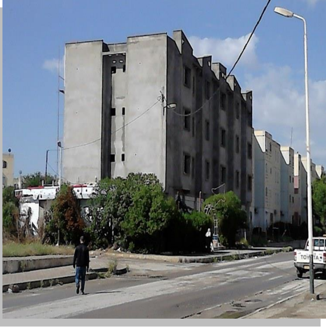
الصورة رقم 3 : عيادة متعددة الخدمات تحت الانشاء
