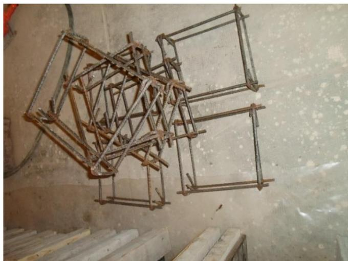
**Figure 2. 7 : Préparation du ferrailage**
