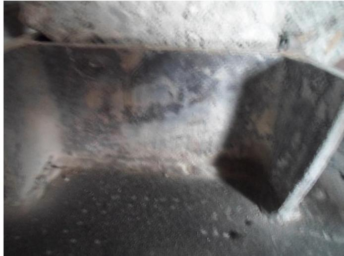
**Figure 2. 27 : Déformation du connecteur en position P03**
