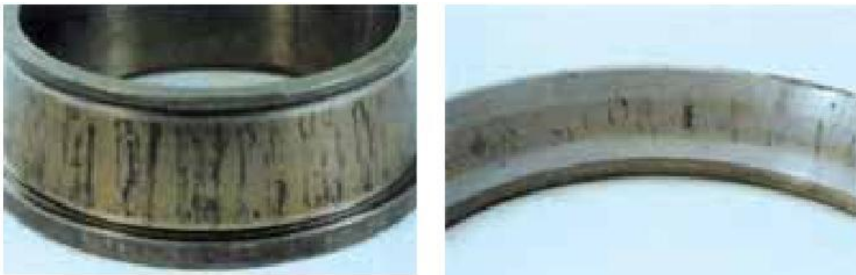
Figure 15 : corrosion des pistes [10].
