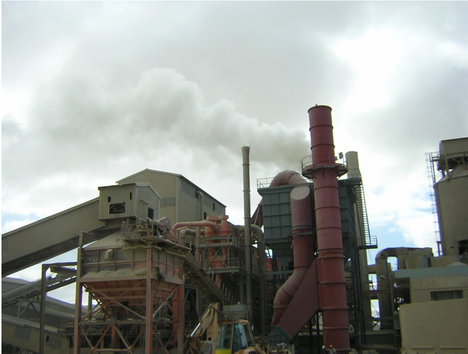
Figure II.3. Voie sèche (Dépoussiérage).
