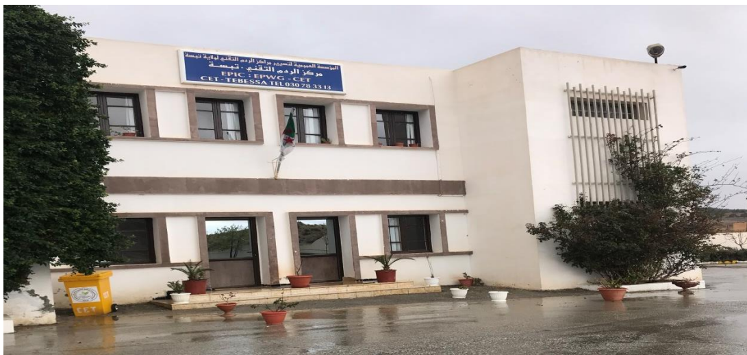
Figure III.41 : bâtiment administratif EPWC TBS.
