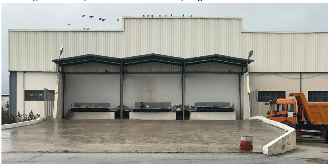
Figure III.43 : point de déchargement des camions pour le triage
