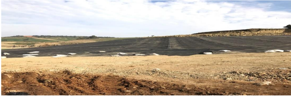
Figure III.27 : casier N°3 en construction (GECETAL)
