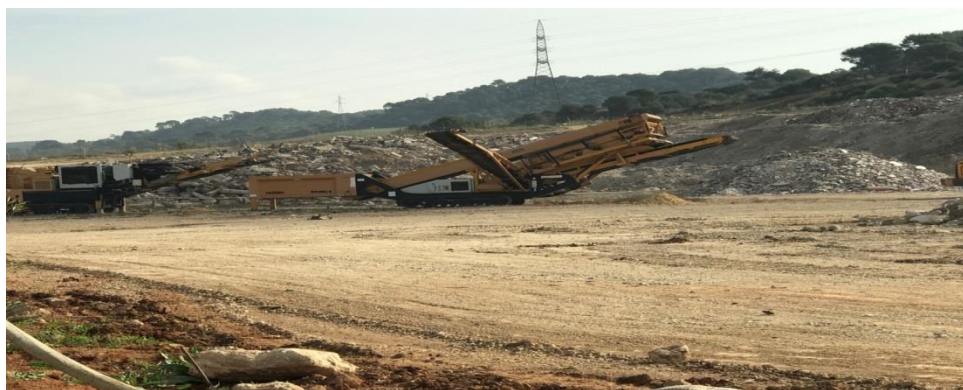
Figure III.31 : Station de concassage des déchets inertes
