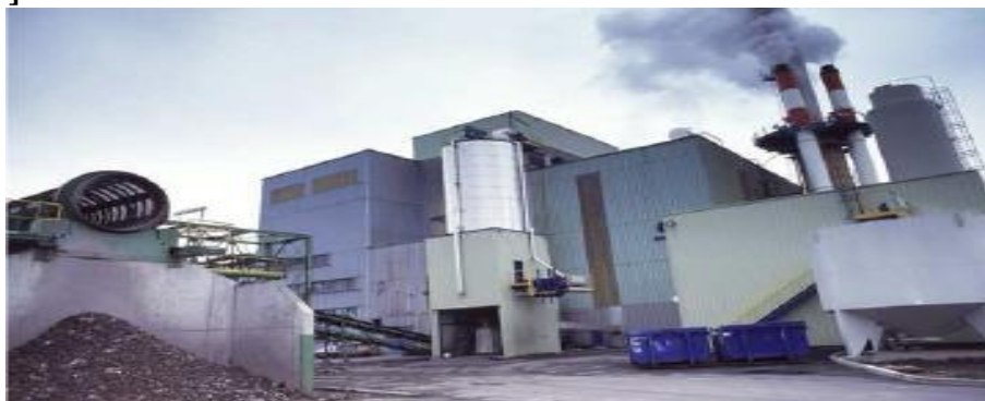
Figure II.8 : vue générale d'une UIOM (saint Ouen/Île de France)
