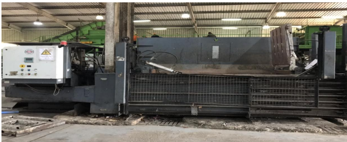
Figure III.34 : presse à balle horizontale défaillante
