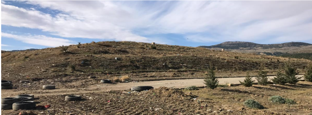
Figure III.48 : casier N°2 en exploitation EPWC TBS
