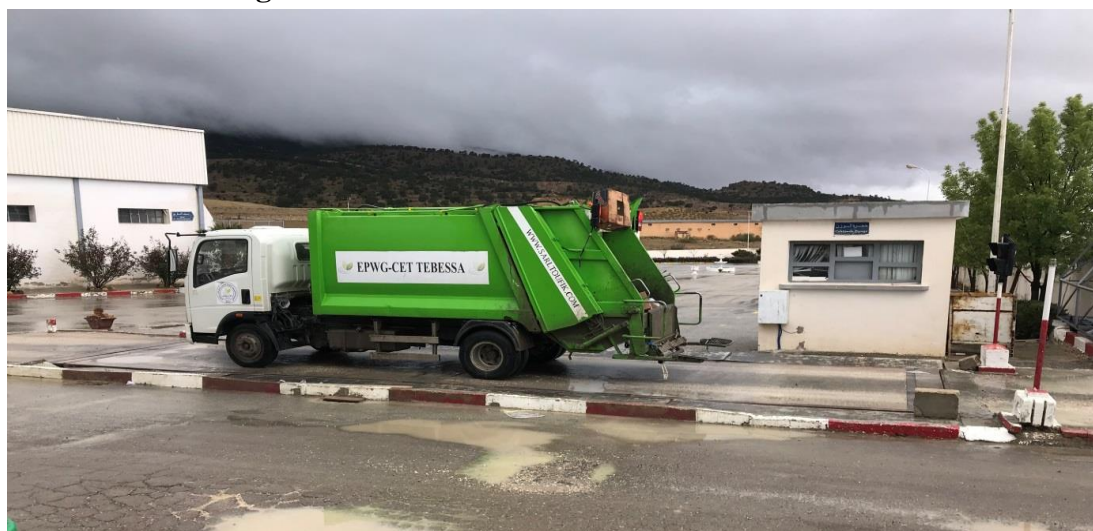
Figure III.42 : pont bascule et cabine de pesage des camions EPWC TBS.
