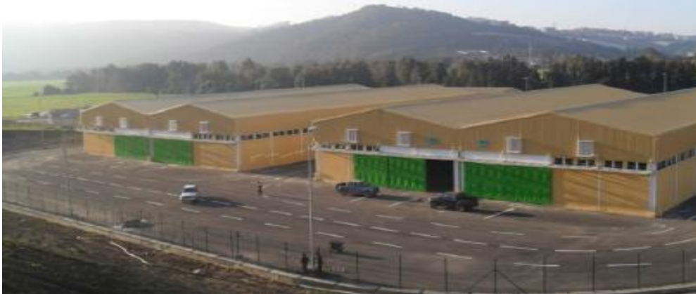
Figure III.17 : les hangars de tri
