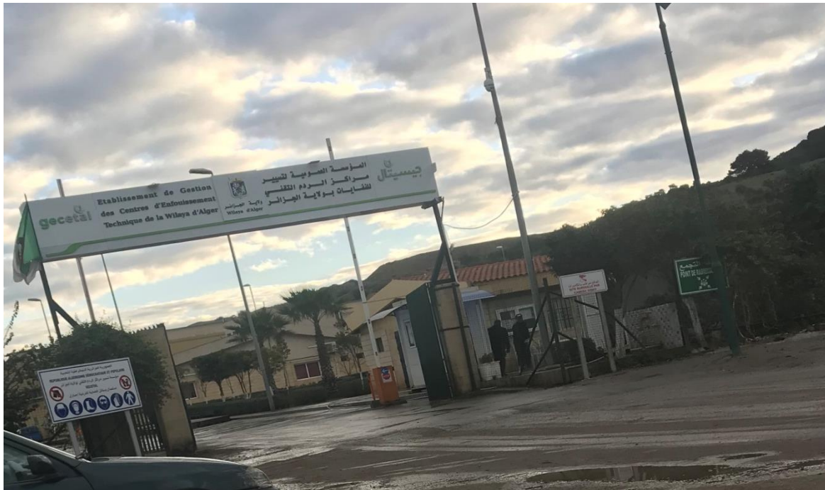
Figure III.13 : centre d'enfouissement technique El Hamici GECETAL-ALGER
