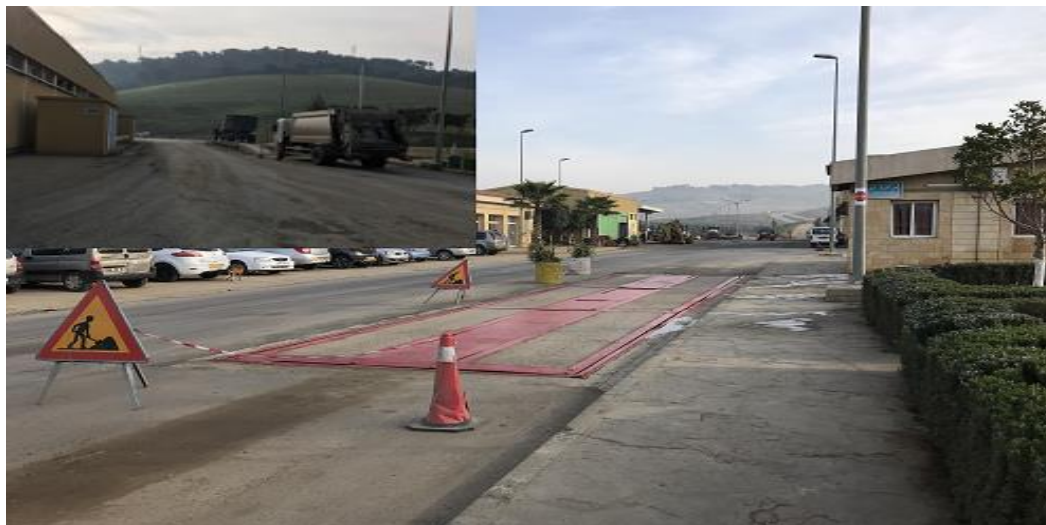
Figure III.15 : pont bascule municipale et celui de réserve.
