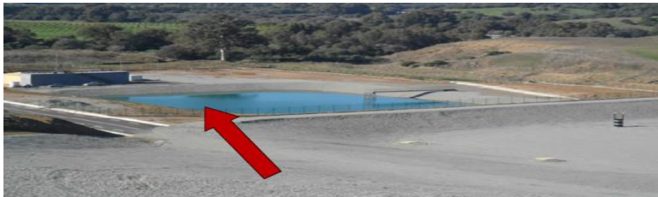
Figure III.28 : bassin des lixiviats (GECETAL)
